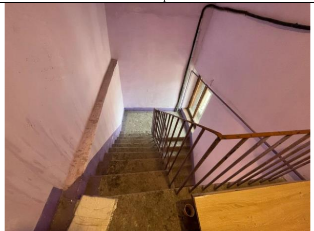
Фото 24. Лестничный проём Объекта оценки
