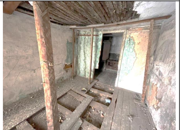
Фото 32. Типичное состояние Объекта оценки
