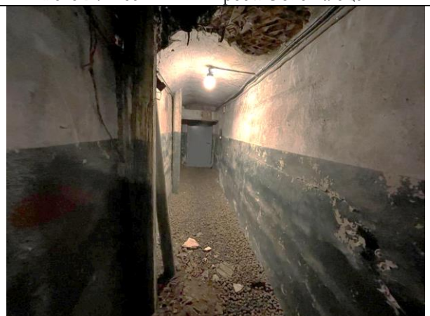
Фото 26. Типичное состояние Объекта оценки
