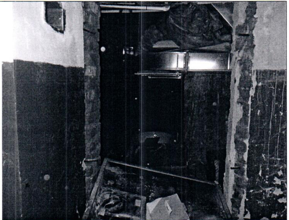
Описание: Вид внутри Объекта
