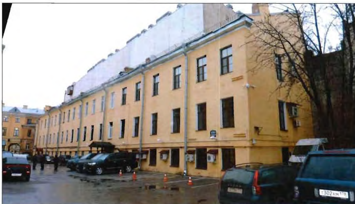
15. Корпус 8, литера Е. Общий вид с юга.
