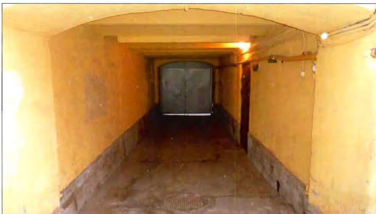
4. Корпус 3, литера В. Северный воротный проезд.
