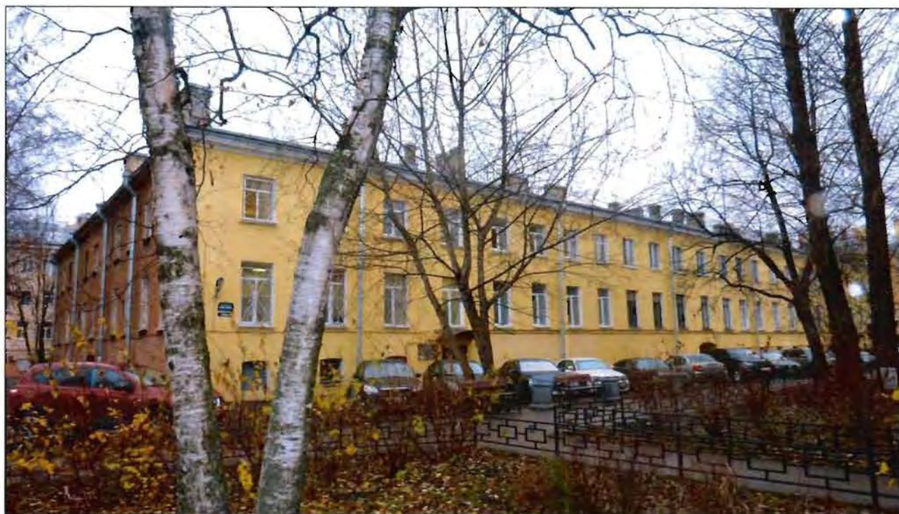
3. Корпус 3, литера В. Общий вид с востока.
