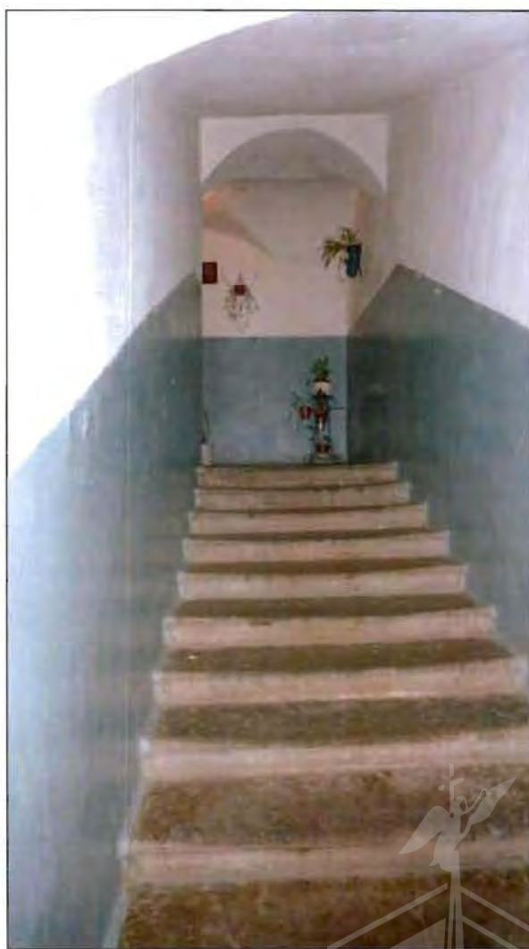
7. Корпус 3, литера В. Лестница (1-ЛК).
