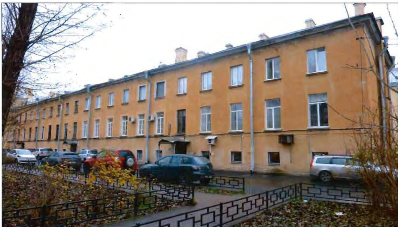
9. Корпус 2, литера Б. Вид с юга.
