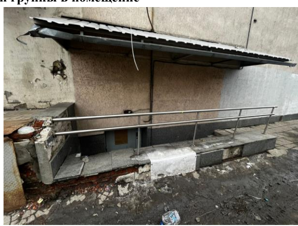
Фото 4. Общий вход с улицы
