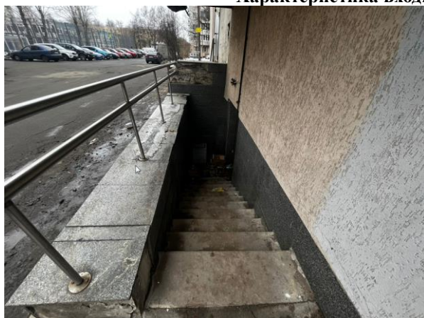
Фото 3. Общий вход с улицы
