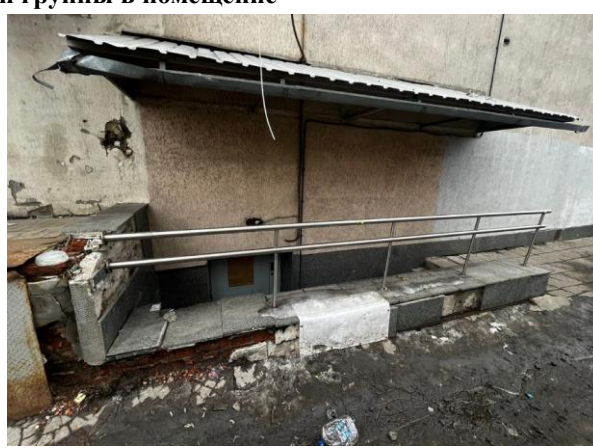
Фото 4. Общий вход с улицы
