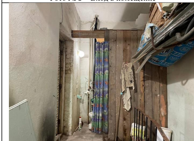
Фото № 11 – Внутреннее состояние помещения
