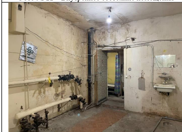
Фото № 13 – Внутреннее состояние помещения
