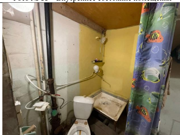
Фото № 12 – Внутреннее состояние помещения
