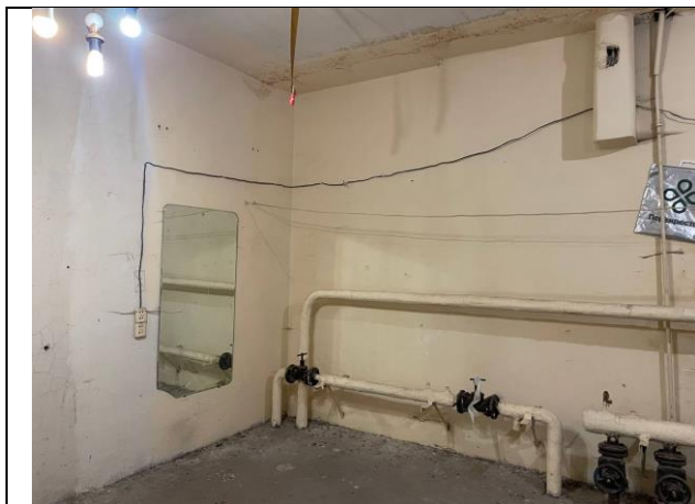
Фото № 15 – Внутреннее состояние помещения
