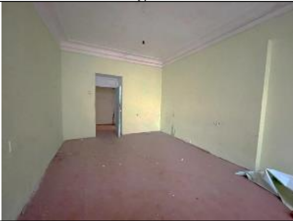
Фото 31. Типичное состояние Объекта оценки
