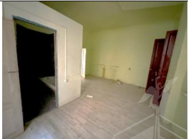
Фото 58. Типичное состояние Объекта оценки
