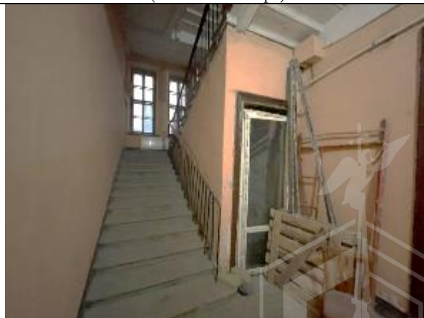
Фото 26. Лестничный проём Объекта оценки
