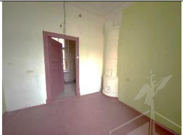
Фото 50. Типичное состояние Объекта оценки
