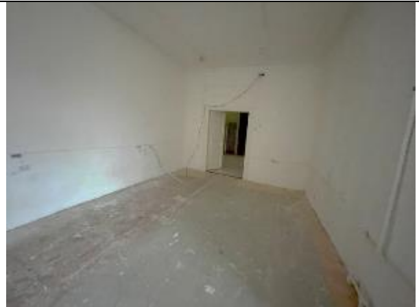
Фото 62. Типичное состояние Объекта оценки
