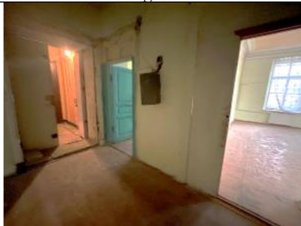
Фото 30. Типичное состояние Объекта оценки
