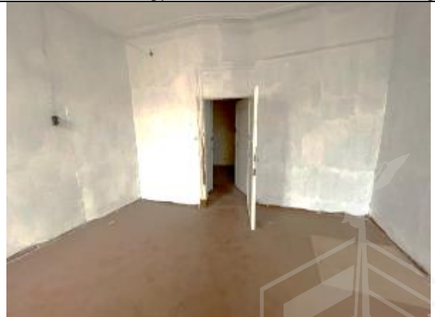
Фото 42. Типичное состояние Объекта оценки
