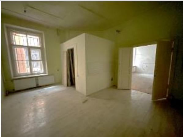
Фото 57. Типичное состояние Объекта оценки
