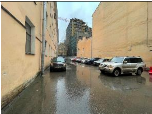
Фото 17. Внутридворовая территория Объекта оценки
