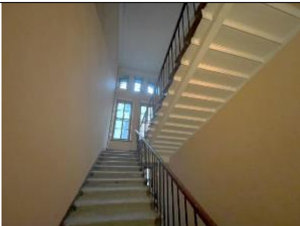
Фото 27. Лестничный проём Объекта оценки
