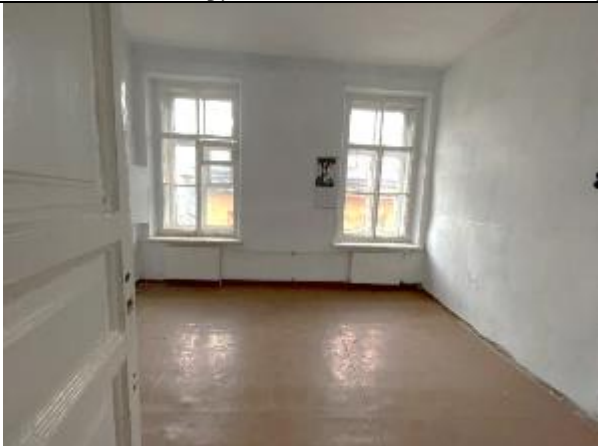
Фото 41. Типичное состояние Объекта оценки
