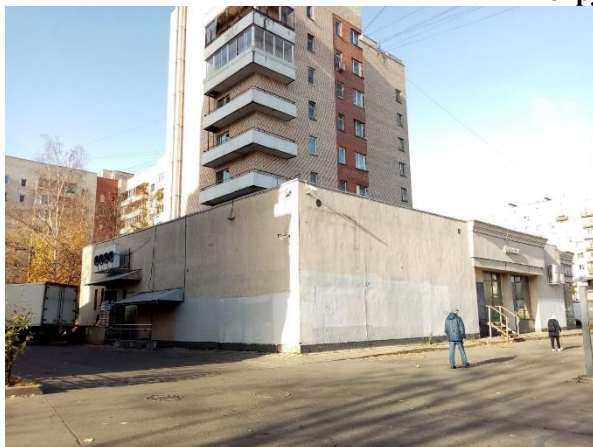
Фото 1. Вид здания Объекта оценки
