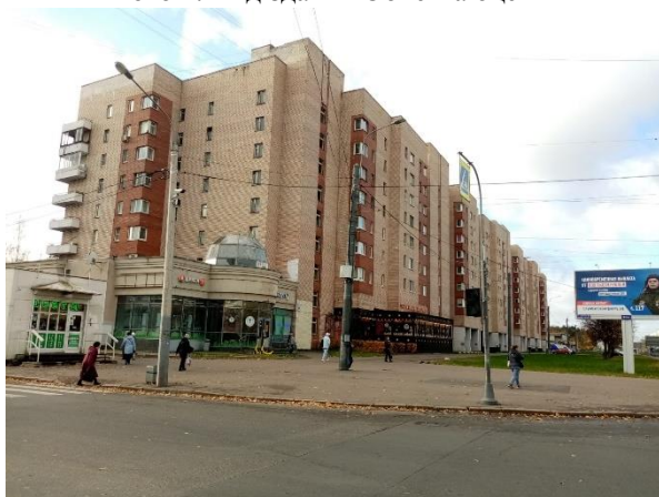
Фото 3. Вид здания и ближайшее окружение Объекта оценки
