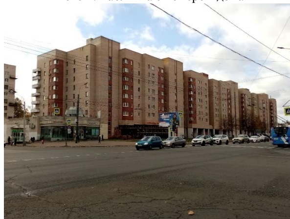
Фото 4. Вид здания и ближайшее окружение Объекта оценки
