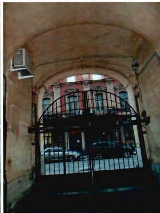
6. Заполнение арочного проема (ворота)
