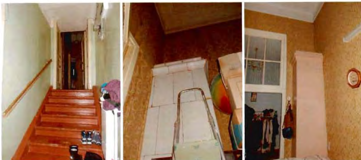
54, 55, 56. Лестница Л-5 (вход со стороны внутреннего двора)
