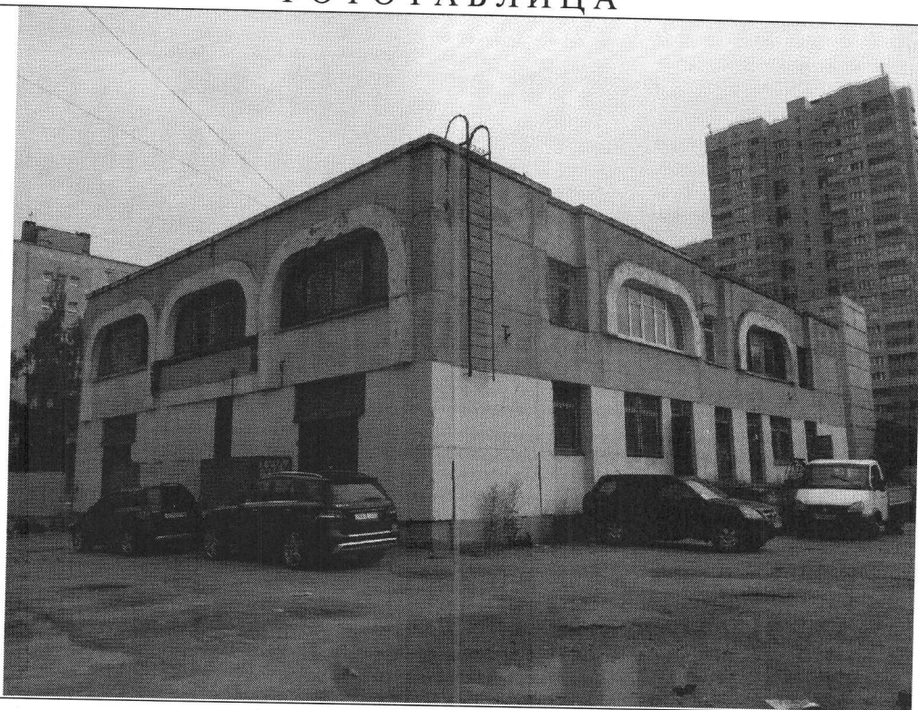
Описание: Вид на Объект.
