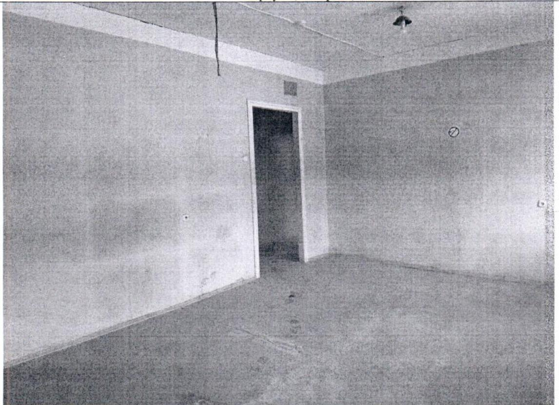
Описание: между ч.п. 2 и 5 Объекта дверной проём переоборудован в проём без дверного блока
