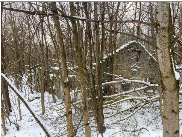
Фото № 3. Внешний вид здания литера З
