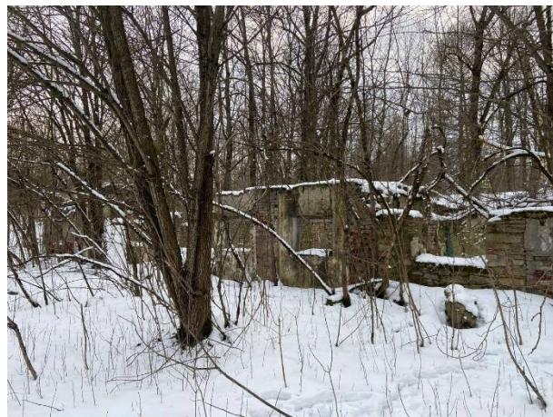
Фото № 10. Внешний вид здания литера А
