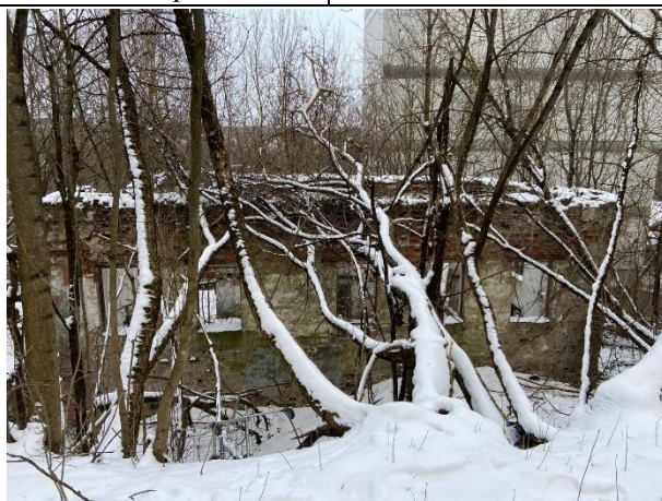
Фото № 11. Внешний вид здания литера А
