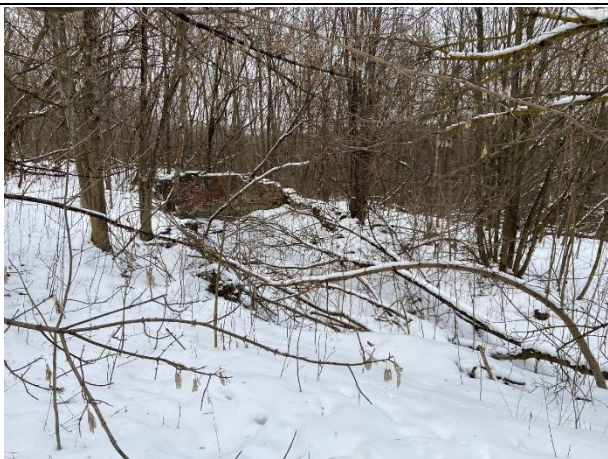
Фото № 9. Внешний вид здания литера Б
