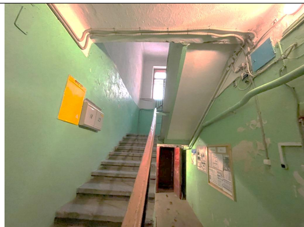
Фото 32. Лестничный проём Объекта оценки
