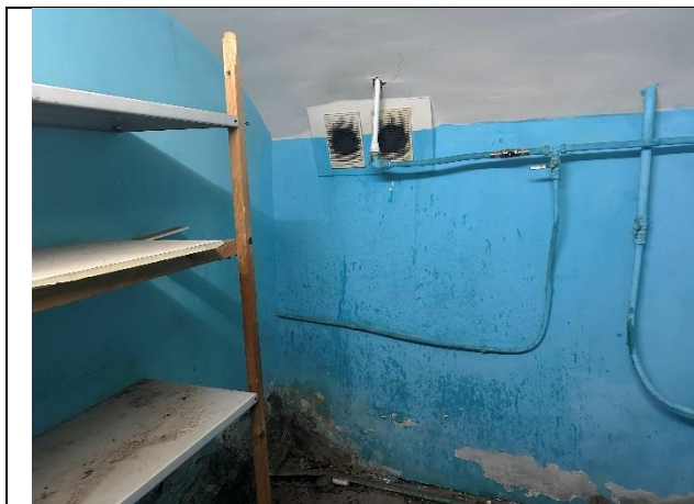
Фото № 13 – Внутреннее состояние помещения
