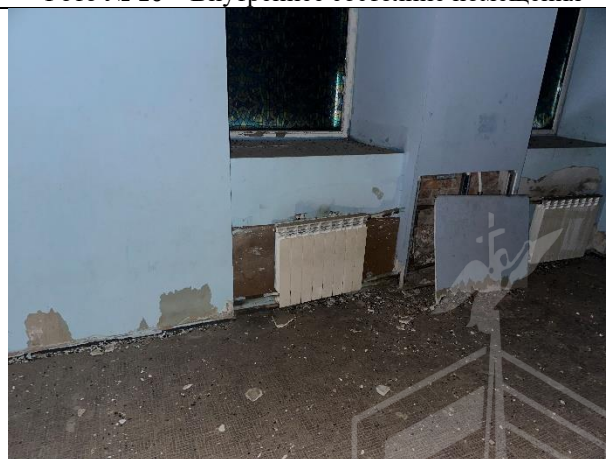
Фото № 12 – Внутреннее состояние помещения
