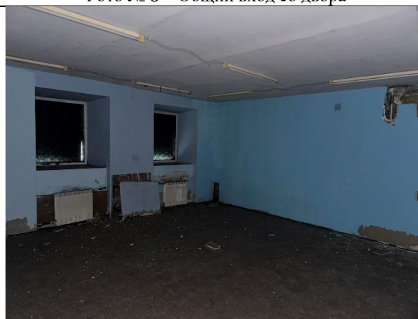
Фото № 10 – Внутреннее состояние помещения
