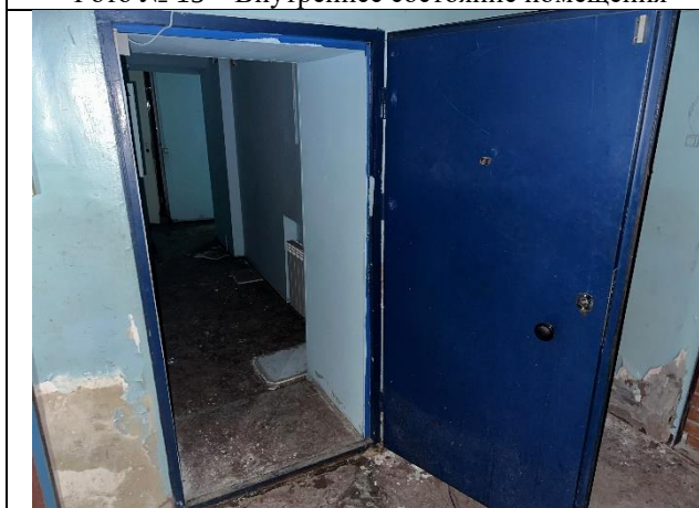
Фото № 17 – Внутреннее состояние помещения
