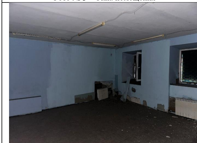
Фото № 11 – Внутреннее состояние помещения
