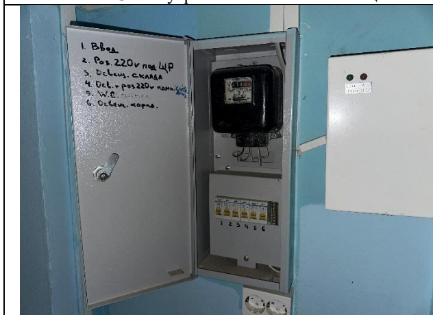
Фото № 15 – Внутреннее состояние помещения
