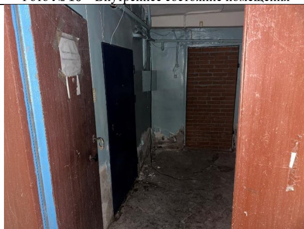
Фото № 18 – Внутреннее состояние помещения
