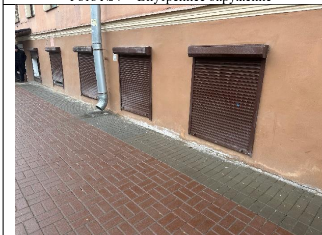
Фото № 9 – Окна помещения
