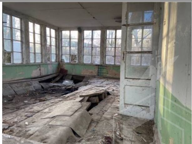
Фото № 8. Внешний вид здания литера Б
