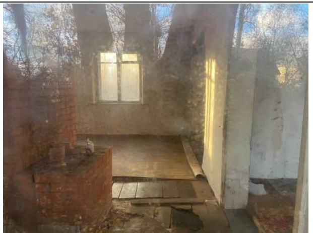
Фото № 9. Внутреннее состояние здание литеры Б
