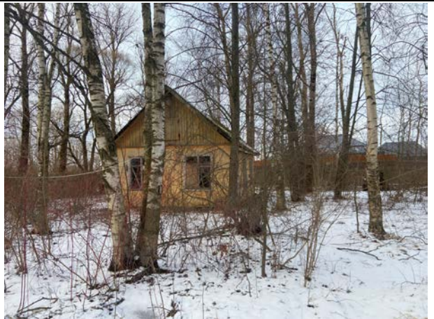
Фото № 11. Внешний вид здания литеры В
