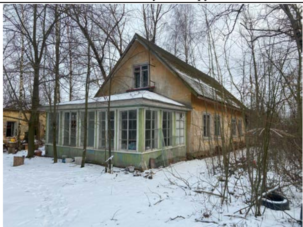
Фото № 5. Внешний вид здания литера А
