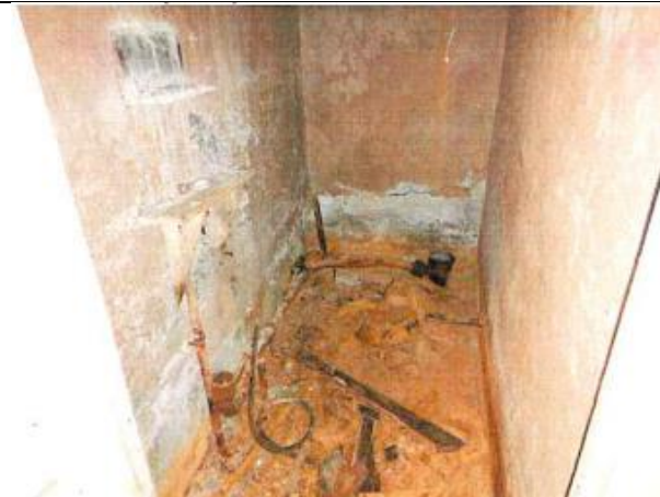
Фото 10. Внутреннее состояние Объекта оценки
