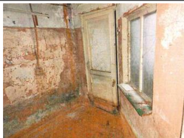
Фото 9. Внутреннее состояние Объекта оценки
