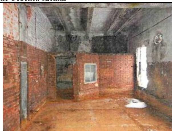
Фото 8. Внутреннее состояние Объекта оценки
