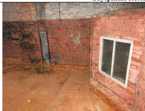
Фото 7. Внутреннее состояние Объекта оценки
