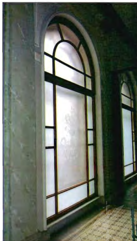
15. Интерьер. Фрагмент. Оконное заполнение.
