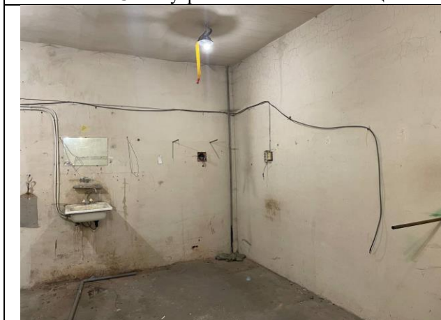
Фото № 17 – Внутреннее состояние помещения
