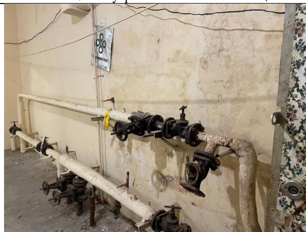
Фото № 18 – Внутреннее состояние помещения
