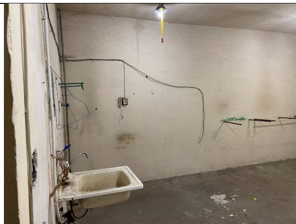
Фото № 16 – Внутреннее состояние помещения
