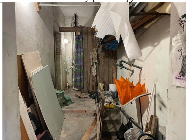
Фото № 10 – Внутреннее состояние помещения
