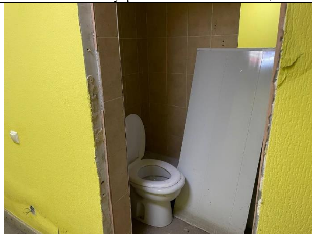
Фото № 24 – Внутреннее состояние помещения
