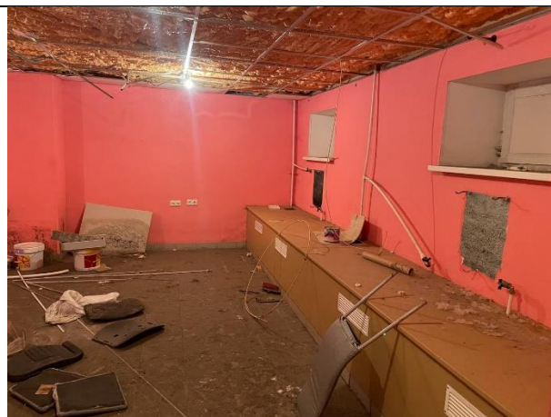
Фото № 14 – Внутреннее состояние помещения
