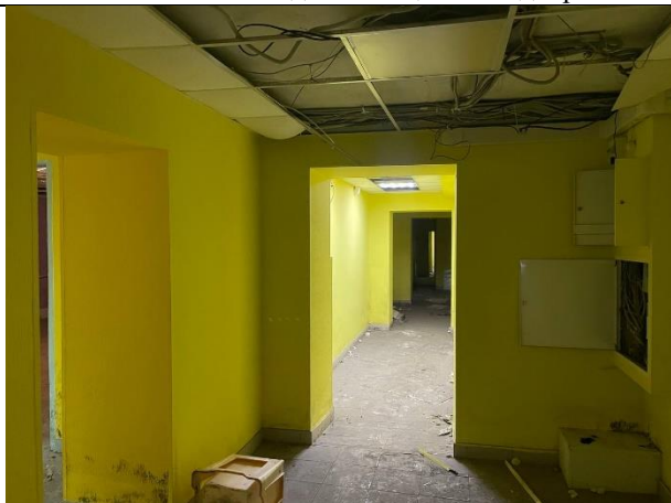
Фото № 11 – Внутреннее состояние помещения
