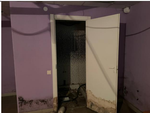
Фото № 21 – Внутреннее состояние помещения
