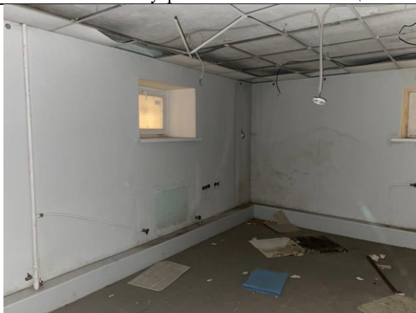
Фото № 27 – Внутреннее состояние помещения
