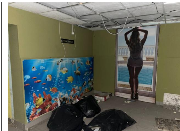
Фото № 29 – Внутреннее состояние помещения
