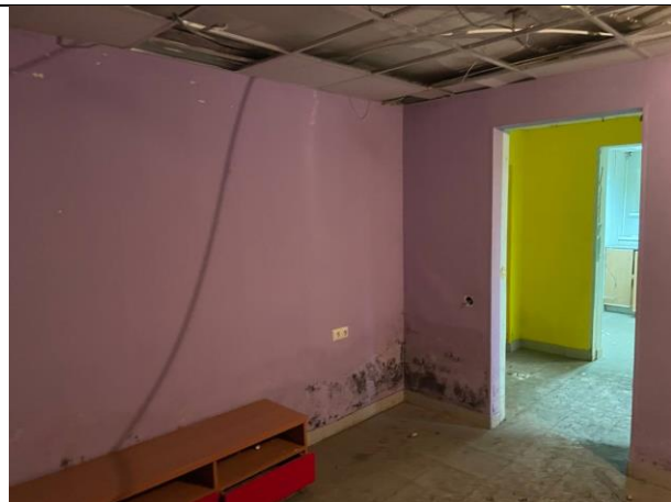
Фото № 22 – Внутреннее состояние помещения
