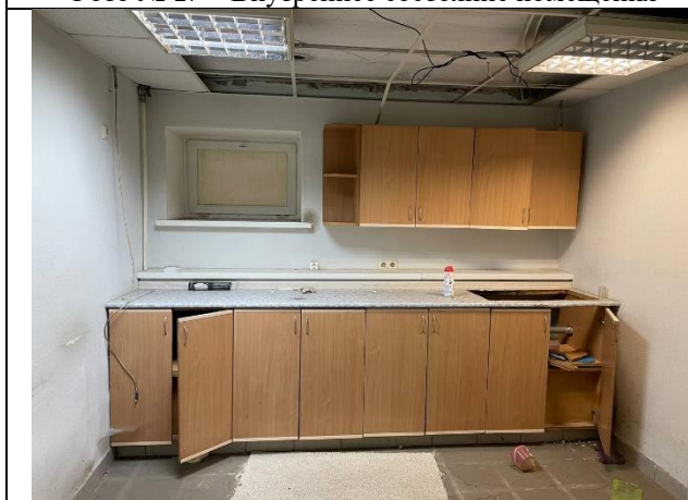
Фото № 19 – Внутреннее состояние помещения
