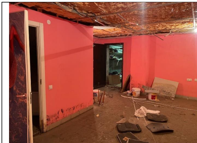
Фото № 13 – Внутреннее состояние помещения
