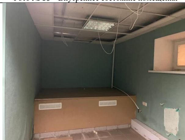
Фото № 18 – Внутреннее состояние помещения
