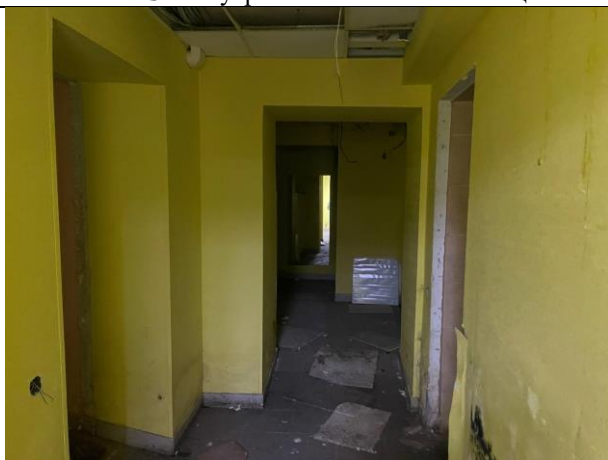
Фото № 25 – Внутреннее состояние помещения
