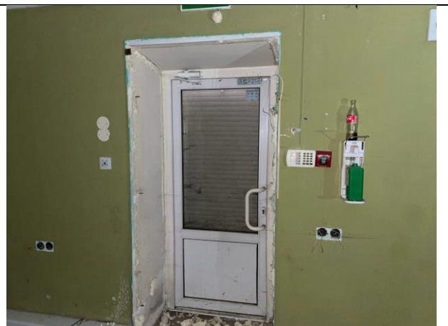
Фото № 30 – Внутреннее состояние помещения
