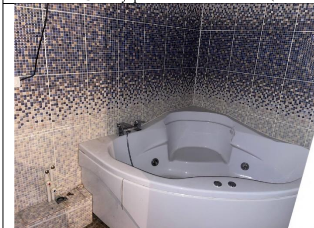
Фото № 15 – Внутреннее состояние помещения
