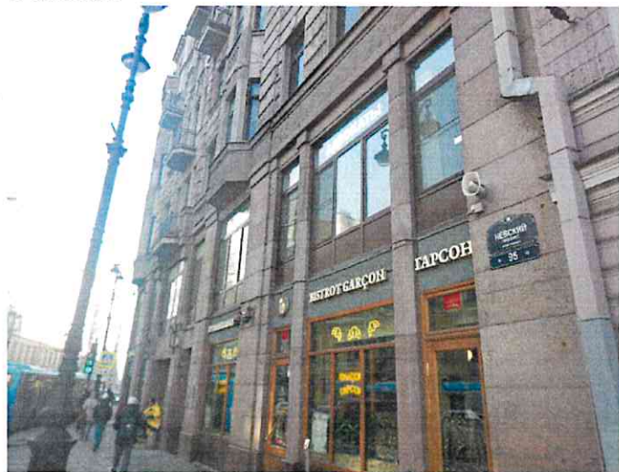
Фото №3 (переоборудованный оконный проем)
