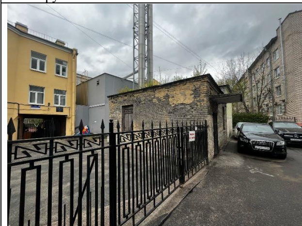
Фото 7. Вид Объекта оценки. Ближайшее окружение. Парковка
