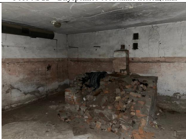
Фото № 13 – Внутреннее состояние помещения
