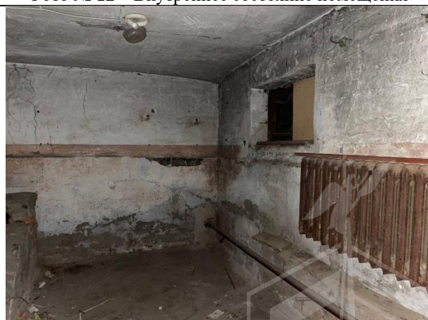
Фото № 14 – Внутреннее состояние помещения
