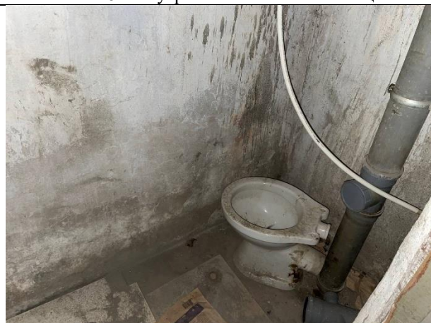
Фото № 18 – Внутреннее состояние помещения
