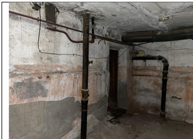
Фото № 15 – Внутреннее состояние помещения
