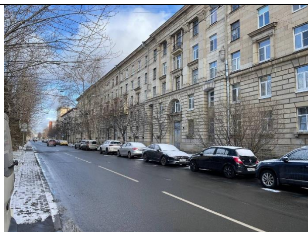
Фото № 2 – Подъездные пути
