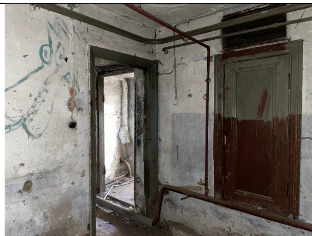
Фото № 24 – Внутреннее состояние помещения
