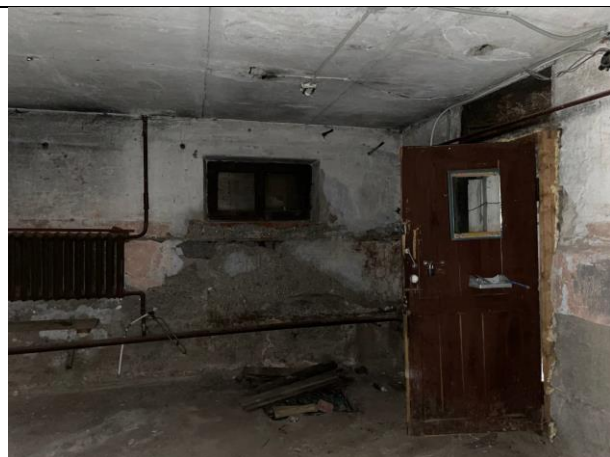
Фото № 16 – Внутреннее состояние помещения
