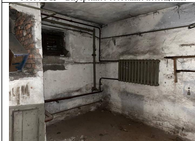
Фото № 21 – Внутреннее состояние помещения
