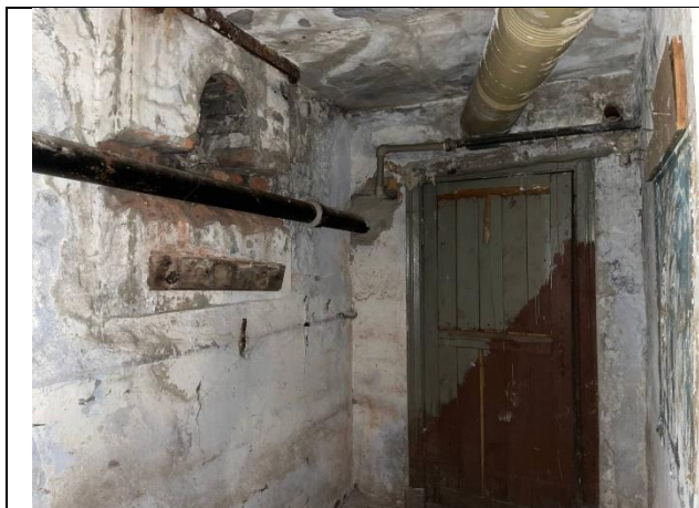
Фото № 23 – Внутреннее состояние помещения
