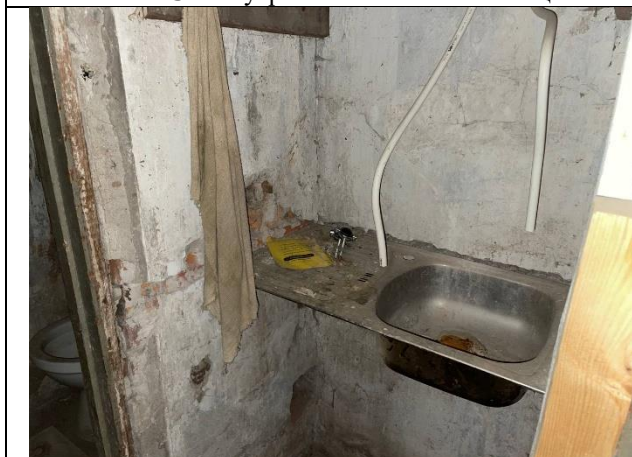
Фото № 17 – Внутреннее состояние помещения
