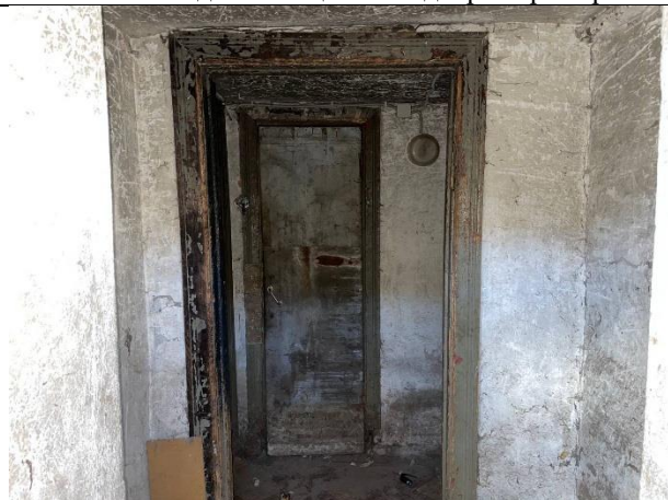
Фото № 10 – Внутреннее состояние помещения
