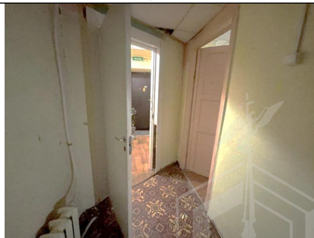
Фото 26. Типичное состояние Объекта оценки, помещение 4-Н
