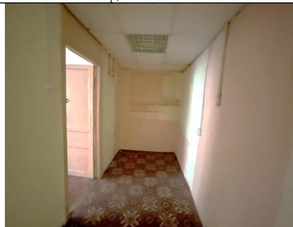
Фото 25. Типичное состояние Объекта оценки, помещение 4-Н
