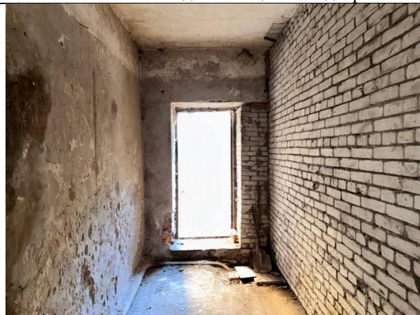
Фото № 10 – Внутреннее состояние помещения
