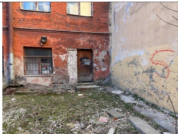
Фото № 8 – Вход в помещение со двора
