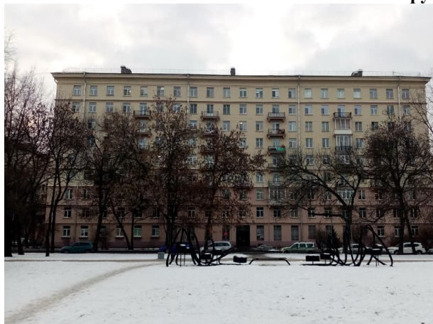
Фото 1. Вид здания, в котором расположен Объект оценки
