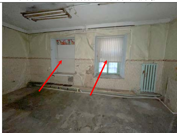
Фото 33. Типичное состояние Объекта оценки, оконная группа Объекта оценки
