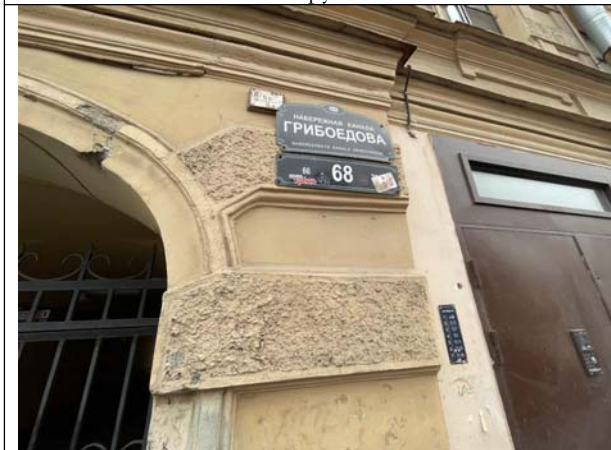
Фото 15. Адрес Объекта оценки
