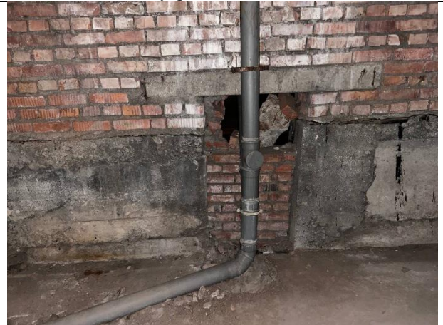
Фото № 20 – Внутреннее состояние помещения
