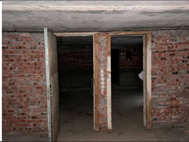
Фото № 17 – Внутреннее состояние помещения
