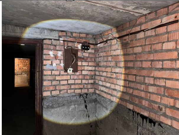
Фото № 19 – Внутреннее состояние помещения
