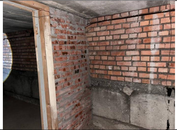
Фото № 18 – Внутреннее состояние помещения
