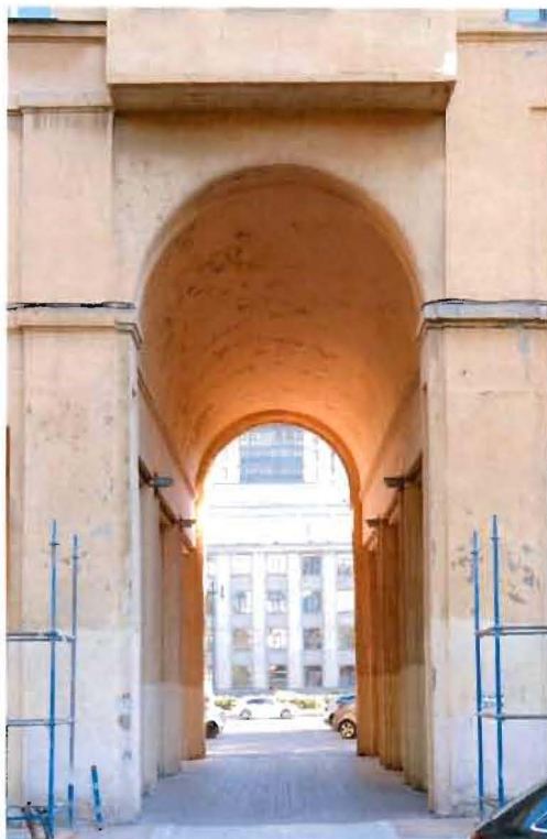
9. Фрагмент. Северная проезжая арка северного флигеля.
