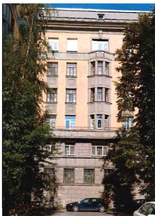
4. Фрагмент. Восточный фасад главного флигеля.
