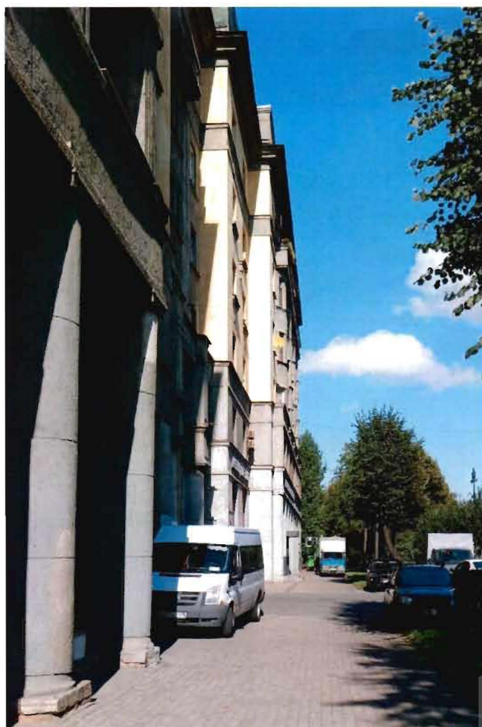
6. Фрагмент. Восточный фасад южного флигеля.
