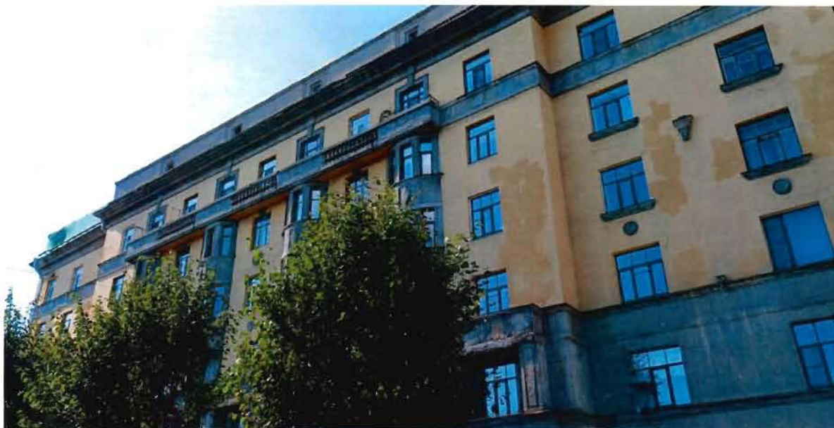
5. Фрагмент. Восточный фасад южного флигеля.
