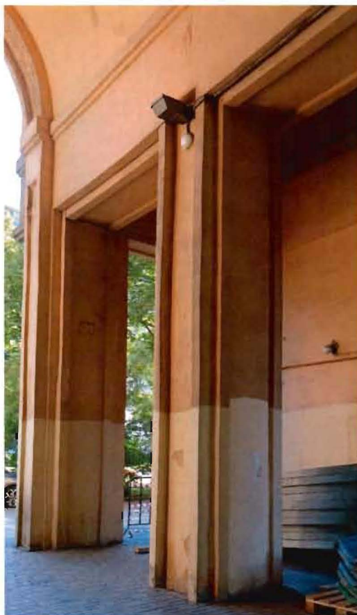
10. Фрагмент. Северная проезжая арка северного флигеля.
