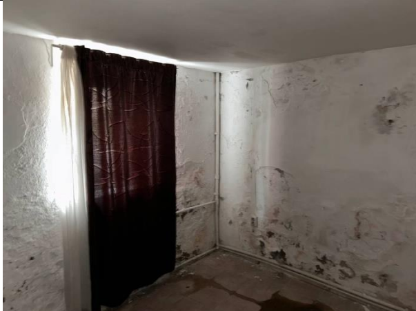
Фото № 15 – Внутреннее состояние помещения 6-Н
