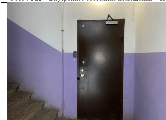
Фото № 25 – Вход в помещение 9-Н
