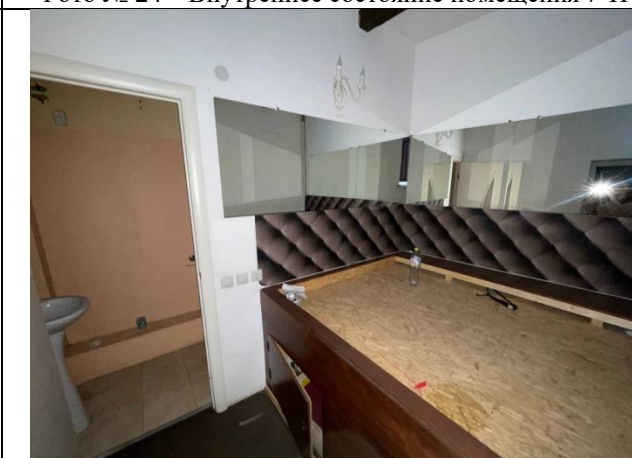
Фото № 26 – Внутреннее состояние помещения 9-Н
