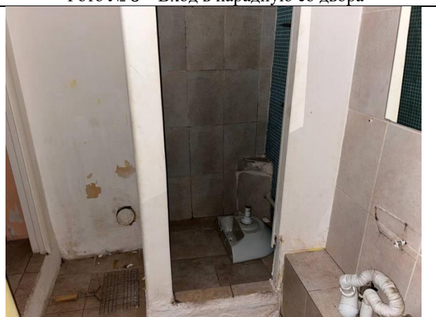
Фото № 10 – Внутреннее состояние помещения 6-Н
