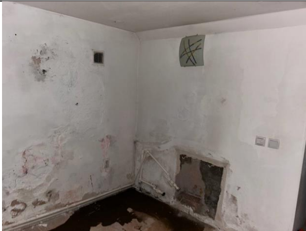
Фото № 13 – Внутреннее состояние помещения 6-Н
