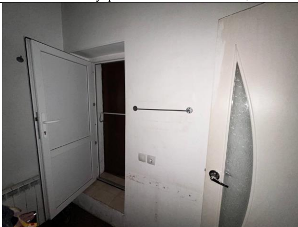
Фото № 17 – Внутреннее состояние помещения 7-Н
