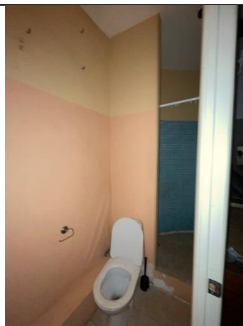
Фото № 30 – Внутреннее состояние помещения 9-Н
