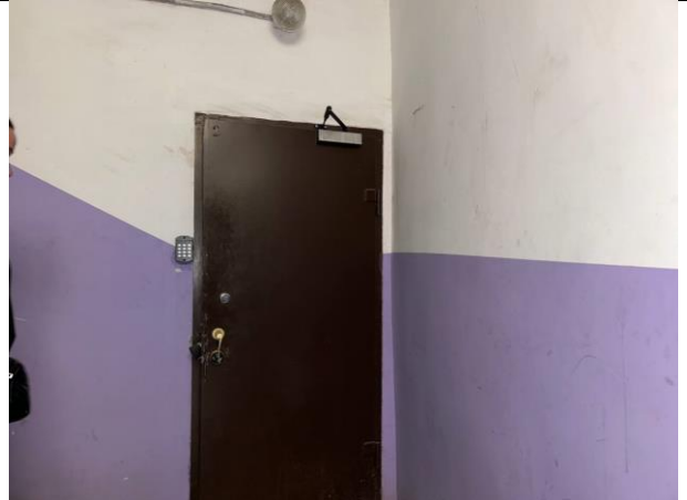
Фото № 16 – Вход в помещение 7-Н
