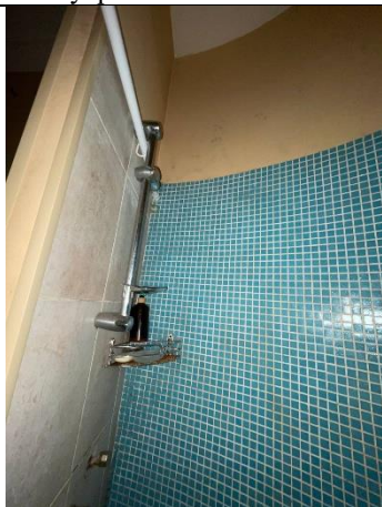
Фото № 31 – Внутреннее состояние помещения 9-Н
