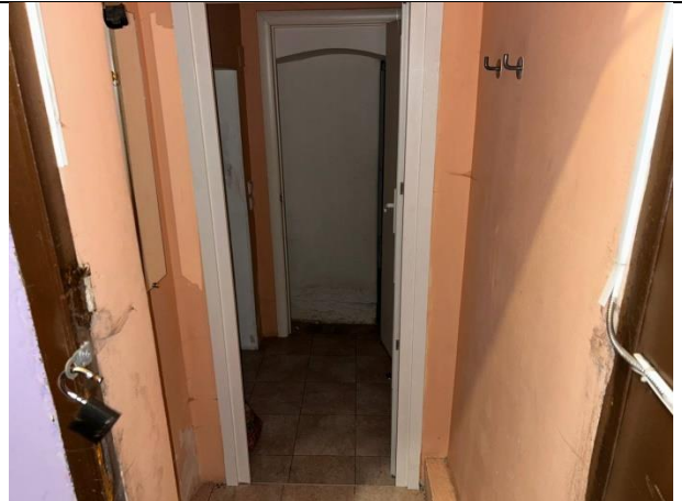
Фото № 14 – Внутреннее состояние помещения 6-Н
