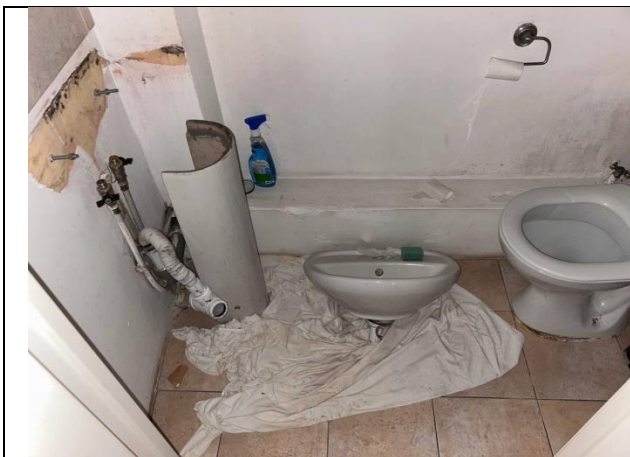
Фото № 21 – Внутреннее состояние помещения 7-Н
