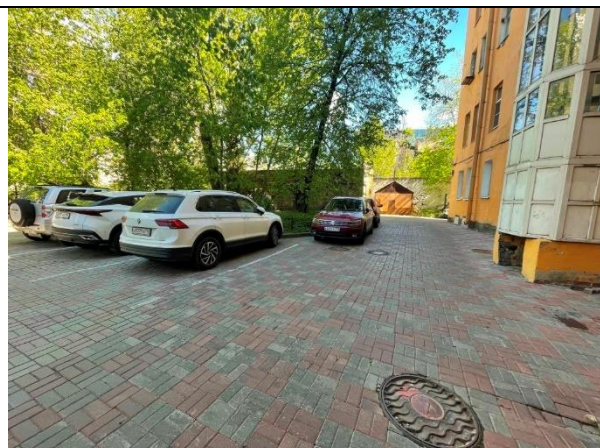
Фото 14. Внутриворовая территория Объекта оценки
