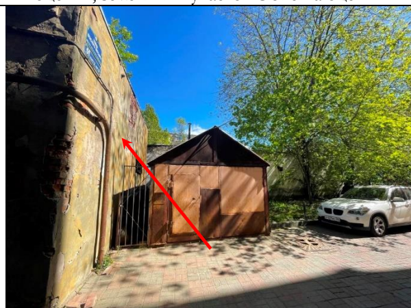
Фото 18. Вид здания расположения объекта оценки
