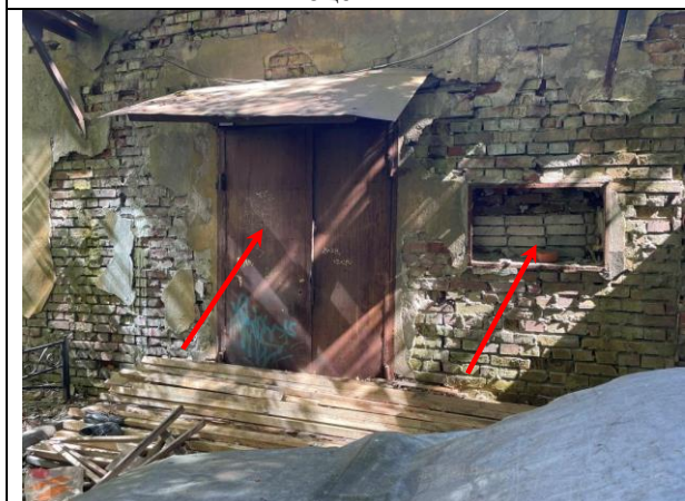
Фото 21. Входная и оконная группа Объекта оценки
