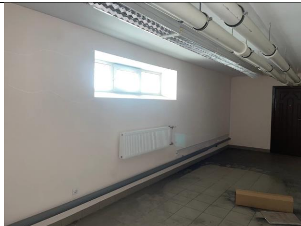
Фото № 30 – Внутреннее состояние помещения
