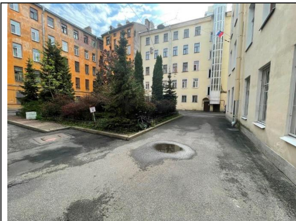
Фото 13. Внутридворовая территория Объекта оценки
