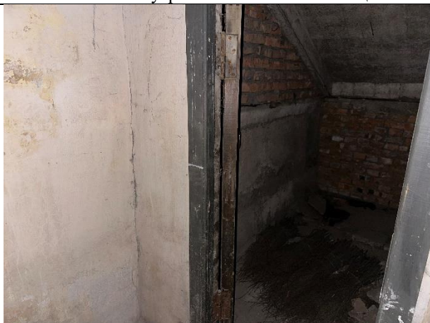
Фото № 11 – Внутреннее состояние помещения
