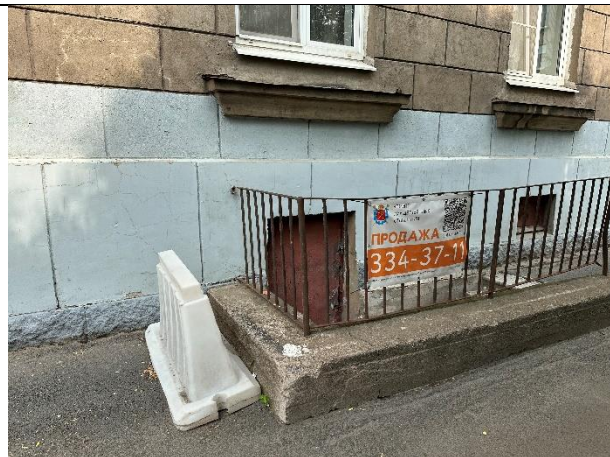
Фото № 6 – Вход в помещение со двора
