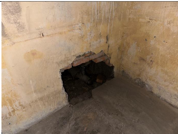
Фото № 13 – Внутреннее состояние помещения
