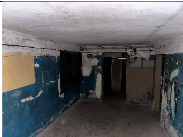
Фото № 14 – Внутреннее состояние помещения
