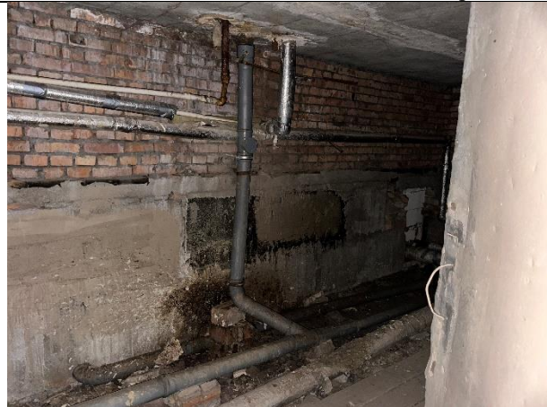
Фото № 8 – Внутреннее состояние помещения
