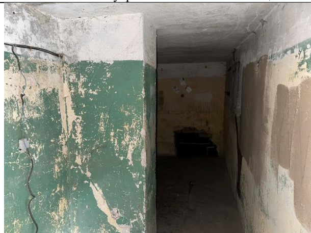
Фото № 16 – Внутреннее состояние помещения
