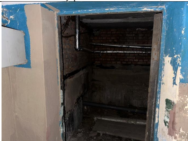
Фото № 9 – Внутреннее состояние помещения
