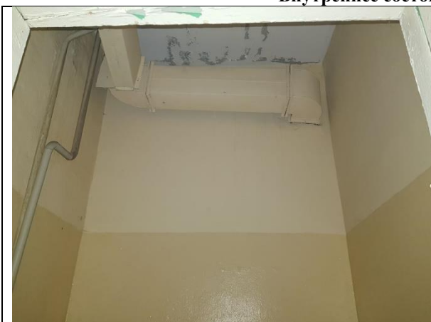
Фото 7. Внутреннее состояние Объекта оценки
