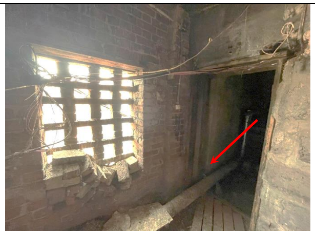
Фото 28. Типичное состояние Объекта оценки (проход на чердак)
