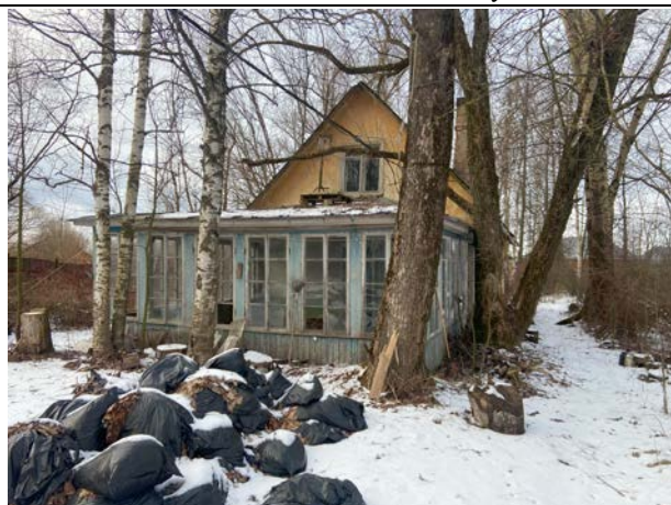
Фото № 6. Внешний вид здания литера А
