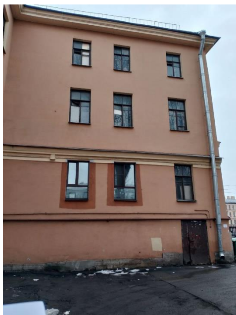
Вход в оцениваемое помещение
