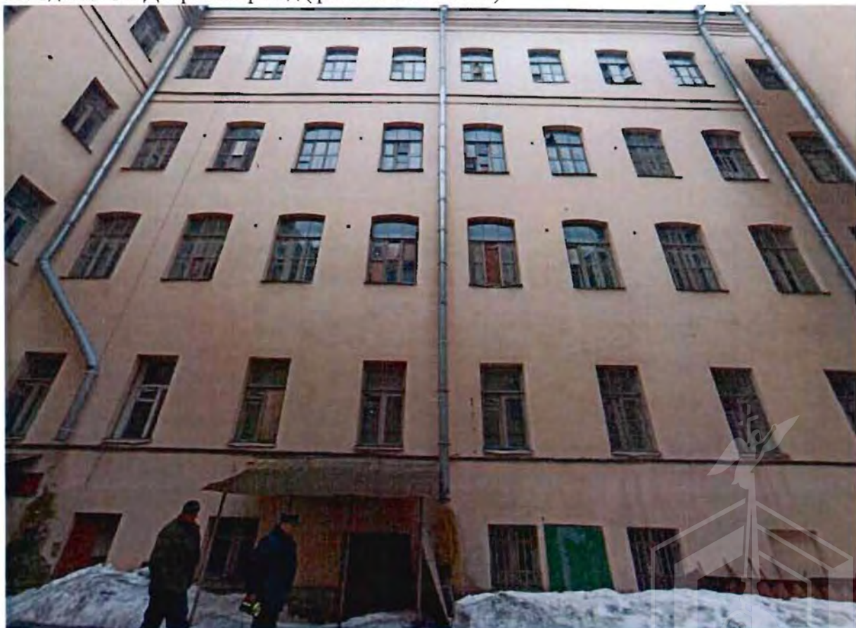
12. Здание 14. Дворовой фасад (фото от 24.03.2023).
