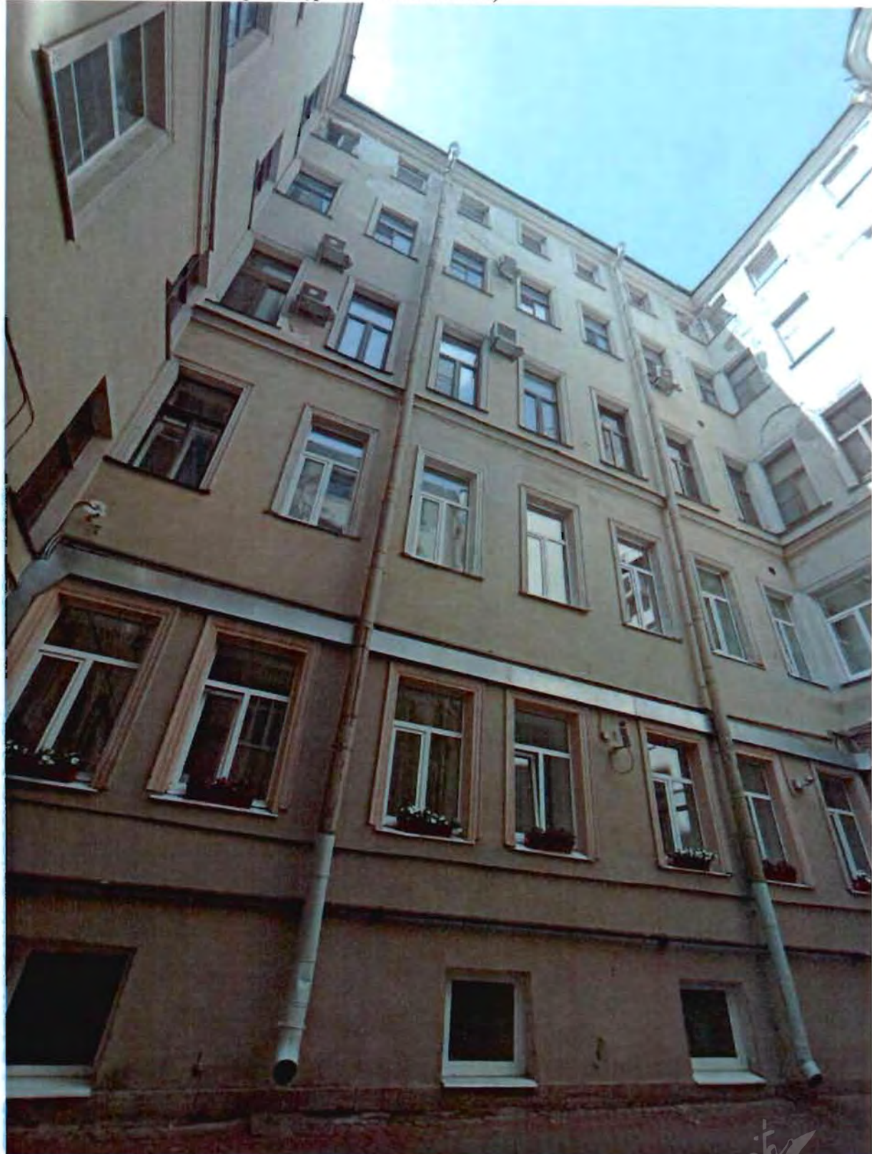
8. Здание 12. Дворовой фасад (фото от 27.06.2023).
