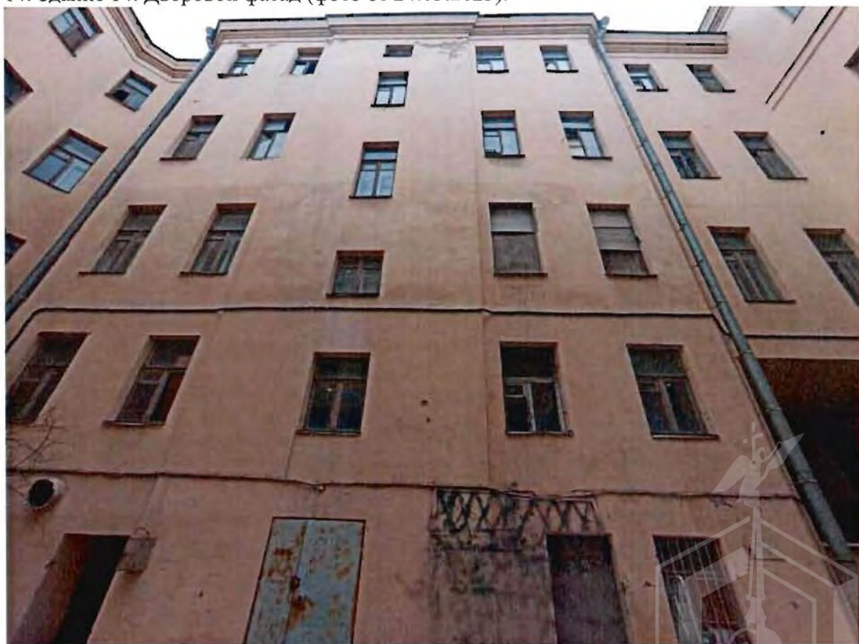
14. Здание 14. Дворовой фасад (фото от 24.03.2023).
