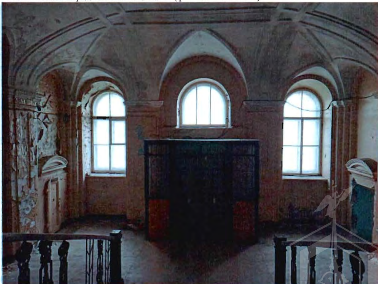
16. Вестибюль парадной лестницы 6ЛК (фото от 24.03.2023).
