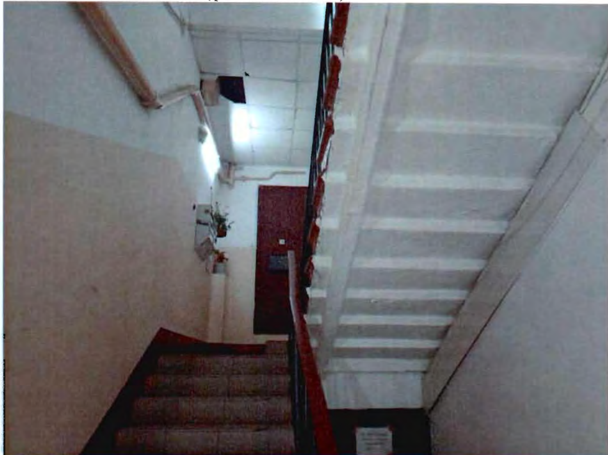
25. Здание 12. Лестница 3ЛК (фото от 27.06.2023).
