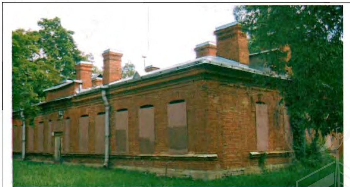
Фото 98. Западный фасад. Общий вид.
