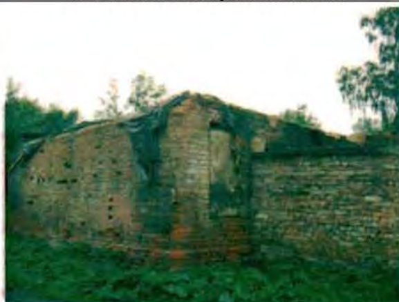
Фото 187. Северный фасад. Общий вид.
