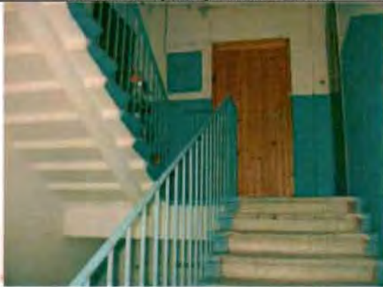
Фото 161. Лестница № 1 в южной части здания. Фрагмент.
