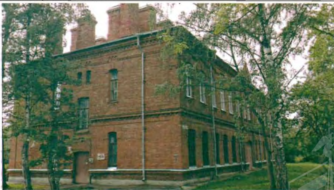
Фото 170. Северный, западный фасады. Общий вид.
