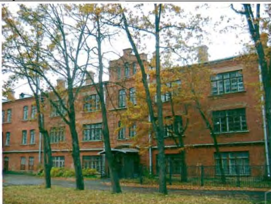
Фото 47. Восточный фасад. Общий вид.
