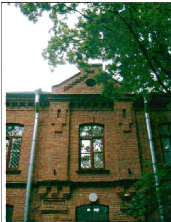
Фото 40. Восточный фасад. Фрагмент центральной части фасада.
