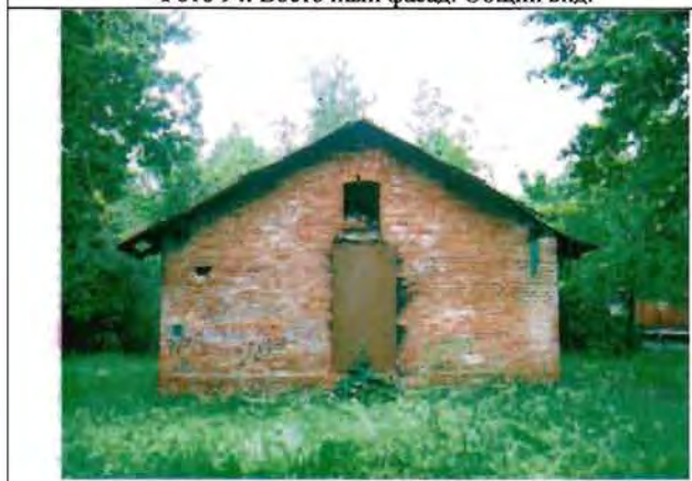
Фото 96. Западный фасад. Общий вид.
