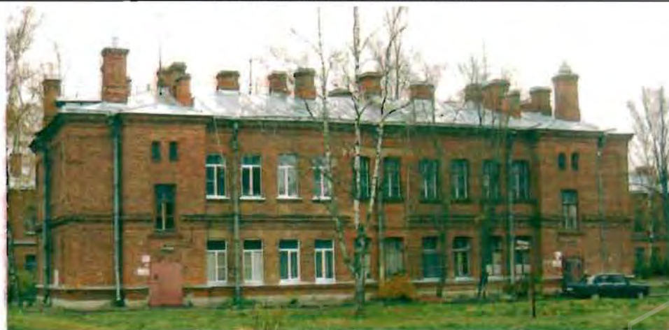
Фото 158. Восточный фасад. Общий вид.
