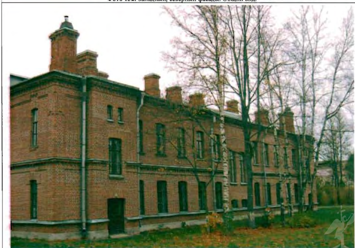
Фото 133. Восточный фасад. Общий вид.
