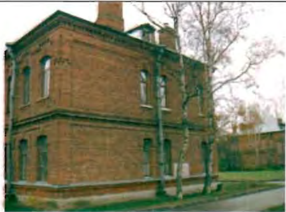
Фото 160. Северный фасад. Общий вид.
