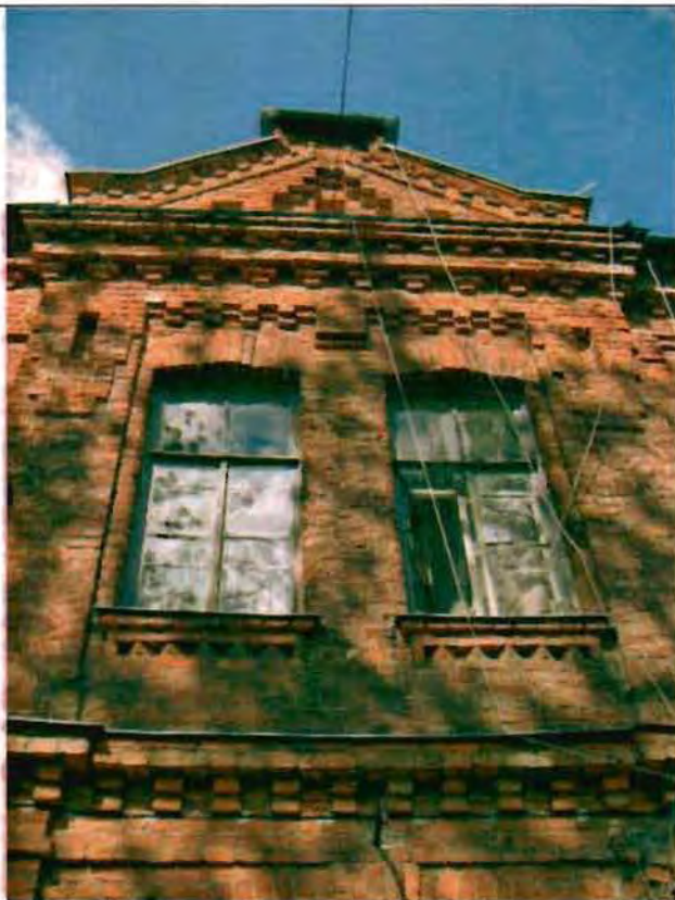
Фото 177. Восточный фасад. Центральная часть. Фрагмент.
