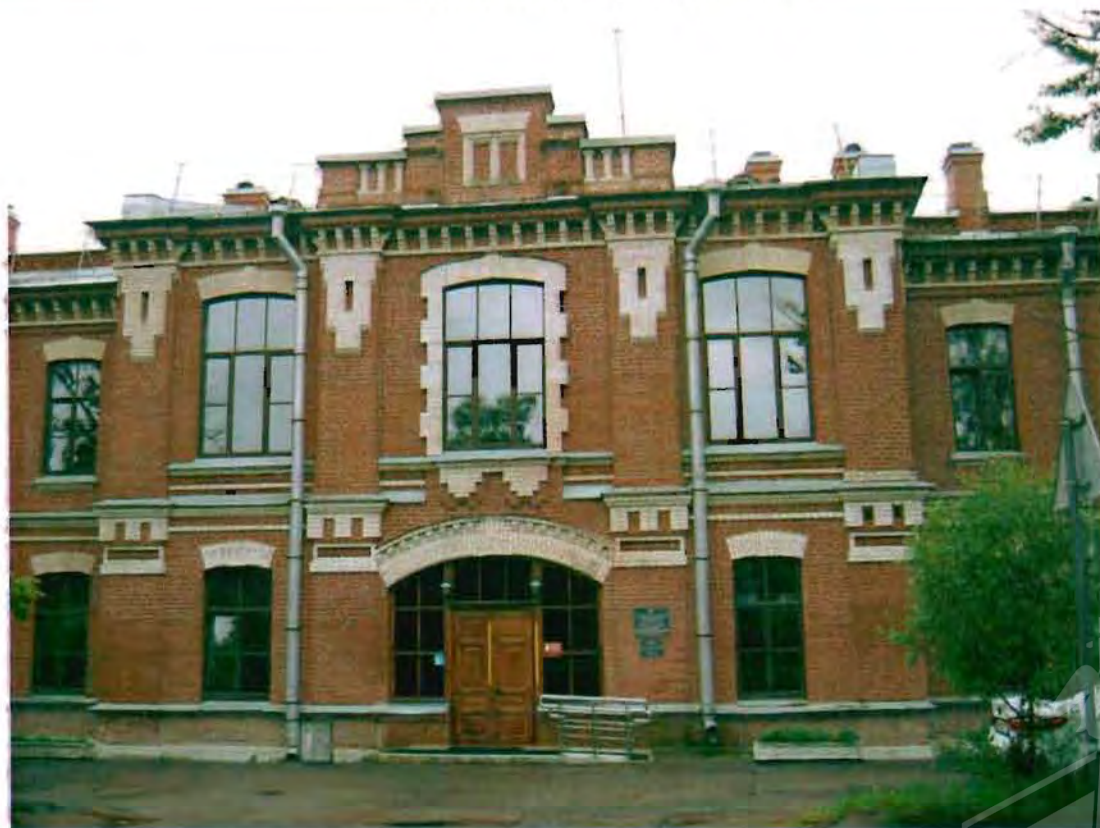
Фото 65. Северный фасад. Фрагмент центральной части фасада.
