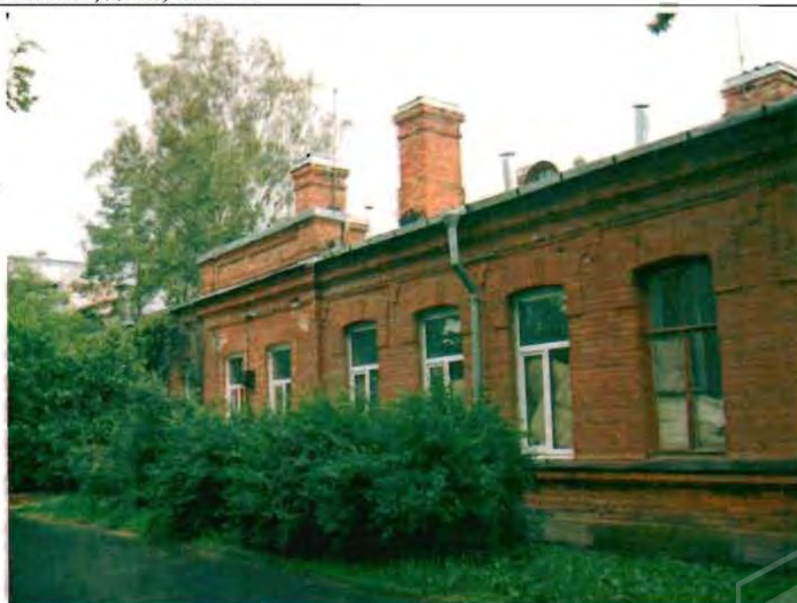
Фото 188. Восточный фасад. Фрагмент.
