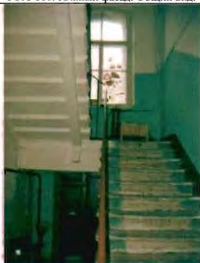
Фото 168. Лестница в южной части здания. Общий вид.
