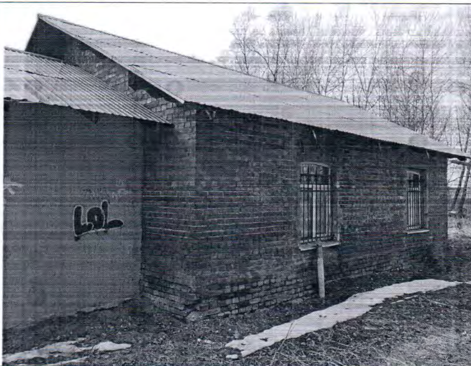
Описание: Вид на Объект
