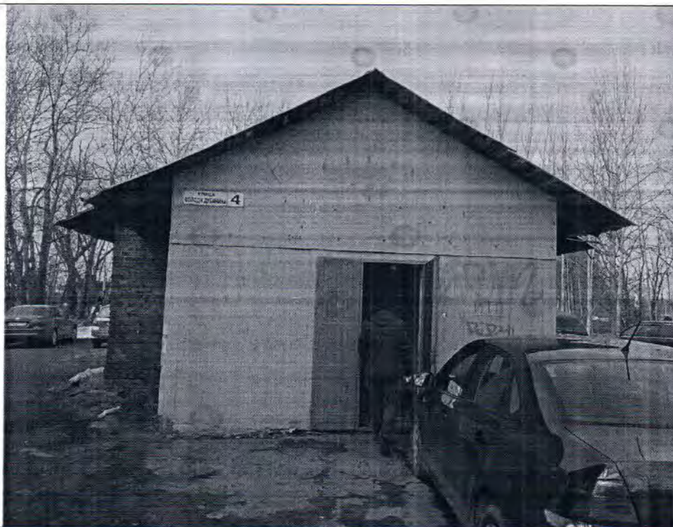
Описание: Вид на Объект
