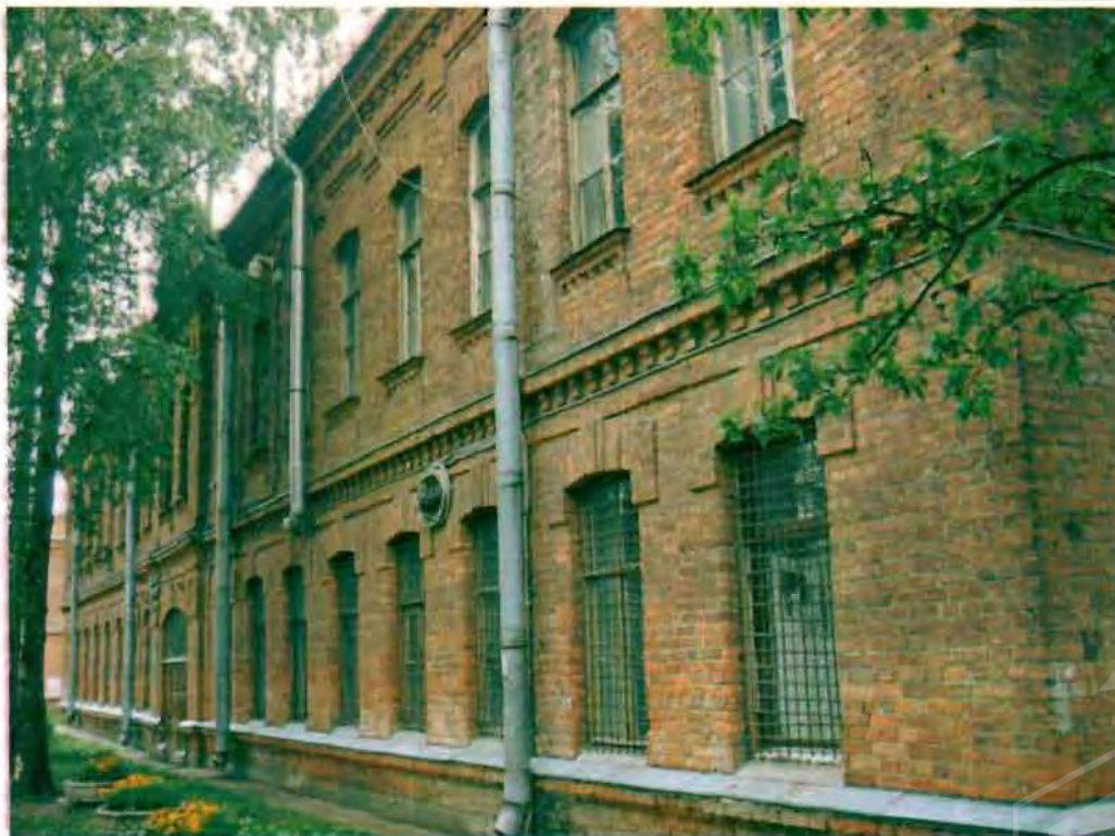
Фото 163. Восточный фасад. Общий вид.
