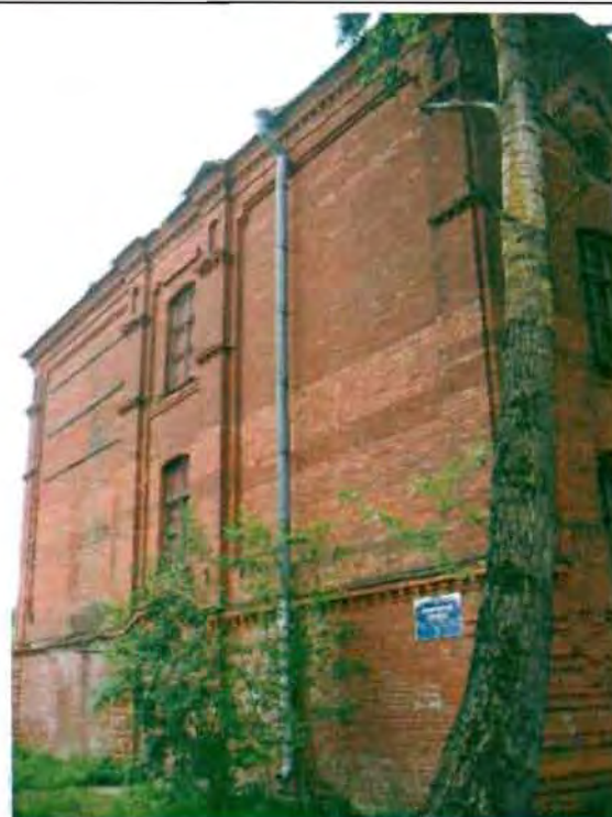
Фото 6. Северный фасад. Общий вид.
