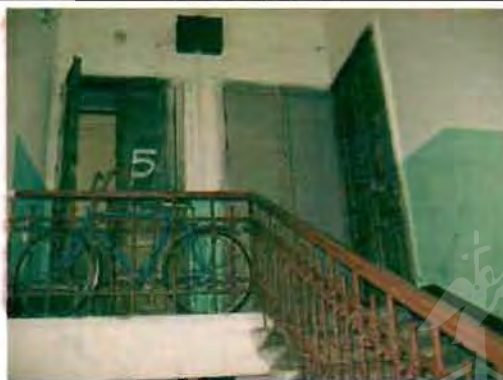
Фото 183. Парадная лестница в центральной части здания. Фрагмент.
