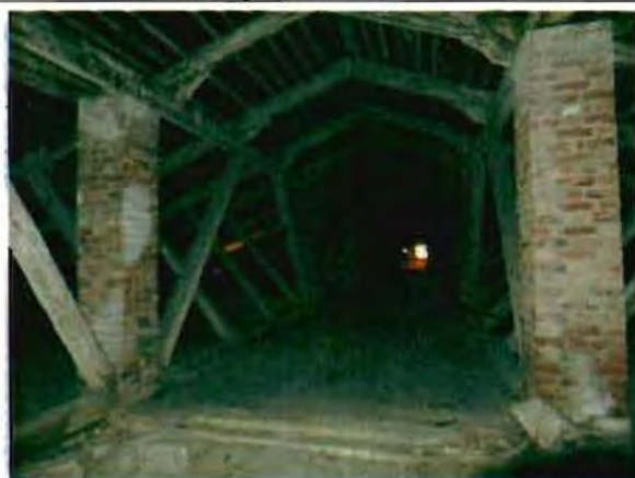
Фото 12. Конструкции крыши. Общий вид. 29.12.2015.
