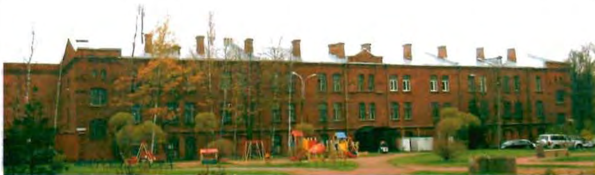
Фото 28. Восточный фасад. Общий вид.
