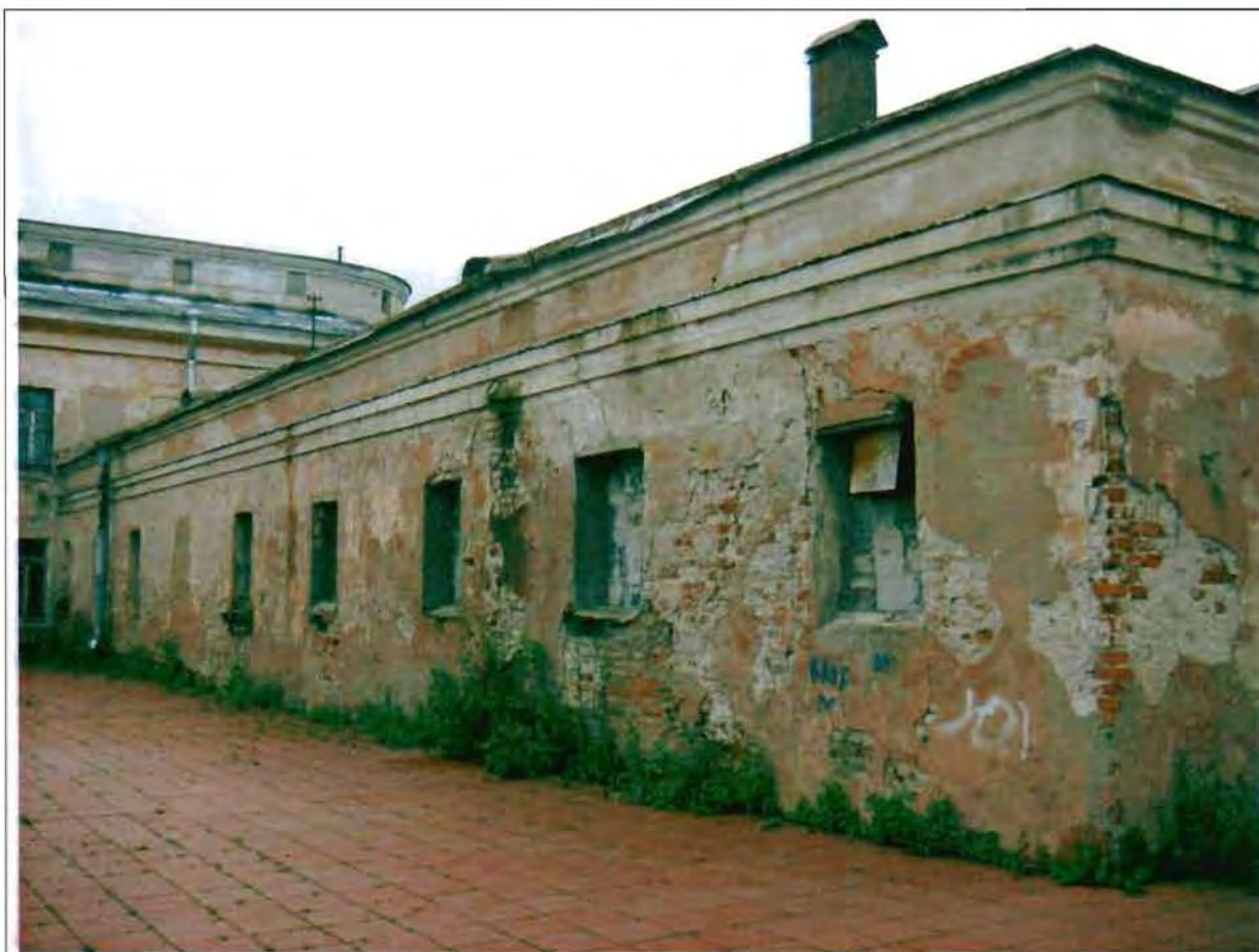
Фото 25. Восточный фасад. Общий вид.
