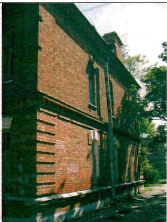
Фото 138. Южный фасад. Общий вид.
