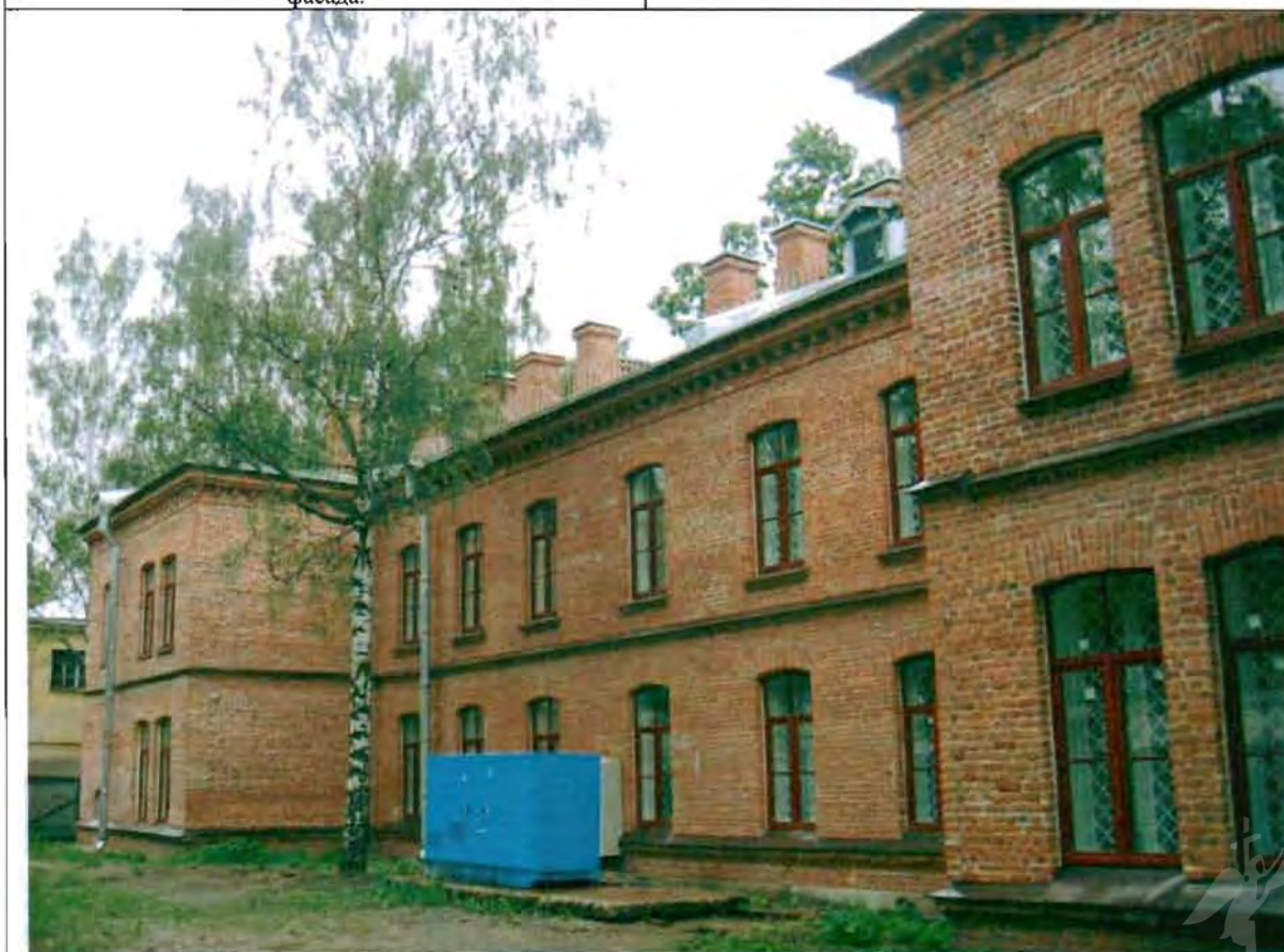
Фото 42. Западный фасад. Общий вид.
