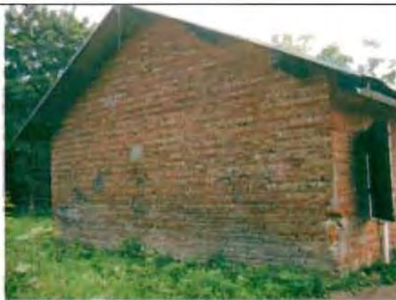
Фото 155. Северный фасад. Общий вид.
