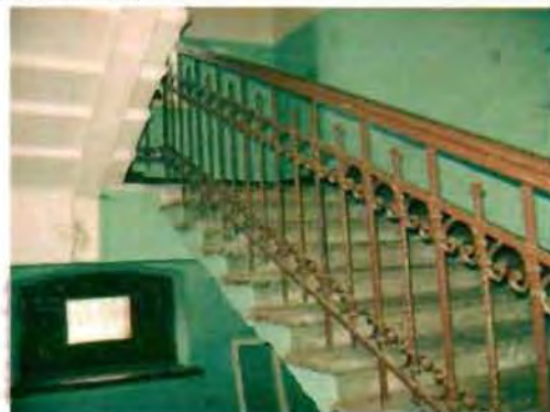
Фото 182. Парадная лестница в центральной части здания. Фрагмент.
