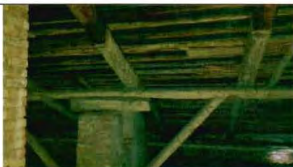
Фото 38. Конструкции крыши. Фрагмент.
