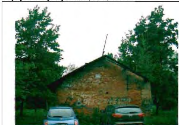
Фото 94. Восточный фасад. Общий вид.
