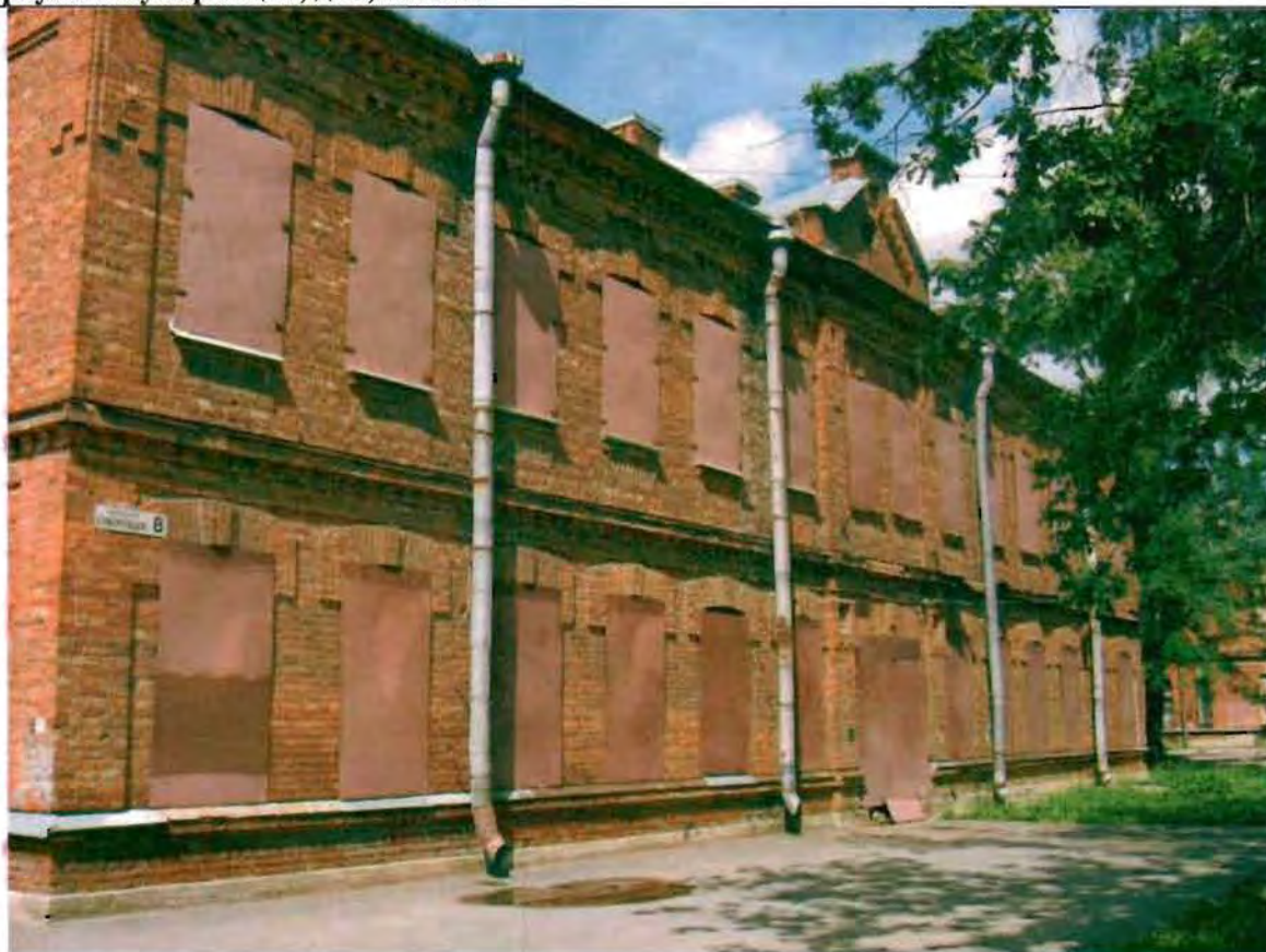
Фото 116. Восточный фасад. Общий вид.
