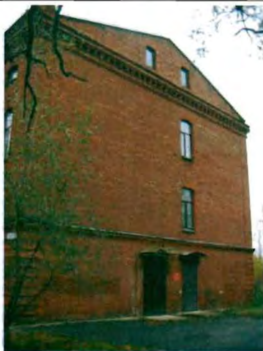
Фото 16. Южный фасад. Общий вид.
