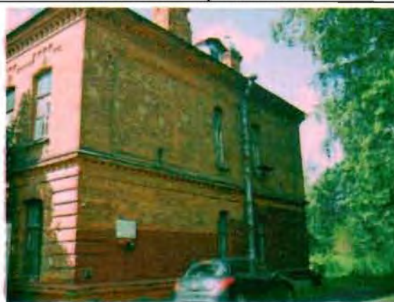
Фото 140. Северный фасад. Общий вид.
