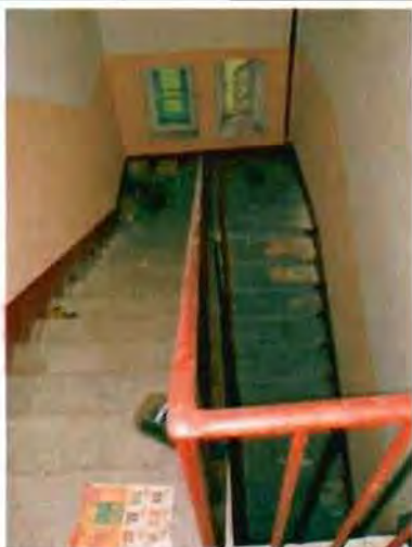
Фото 124. Лестница в южной части здания. Общий вид.
