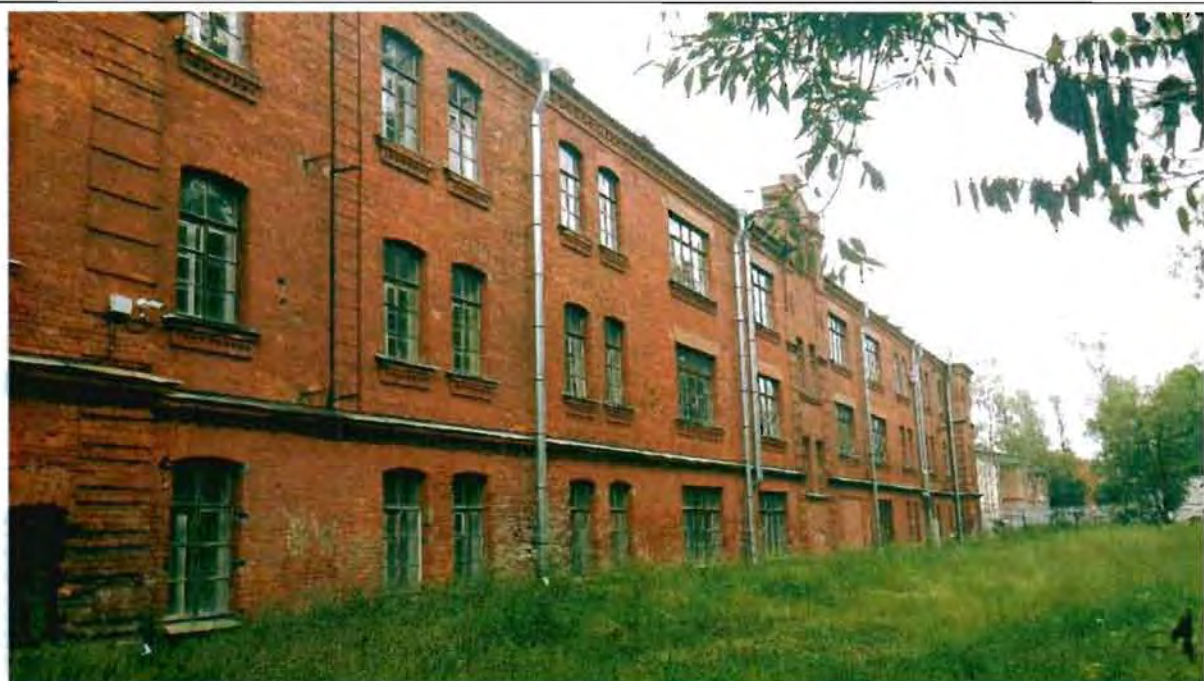
Фото 48. Западный фасад. Общий вид.
