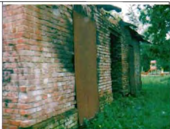
Фото 95. Северный фасад. Общий вид.
