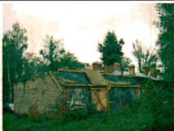
Фото 186. Западный, северный фасады. Общий вид.
