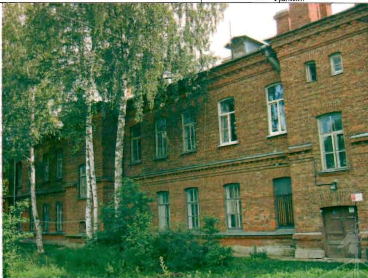
Фото 179. Западный фасад. Общий вид.
