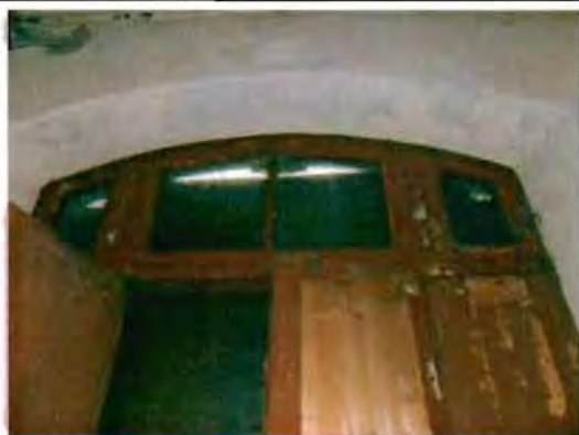
Фото 126. Дверное заполнение центральной части лестницы. Фрагмент.
