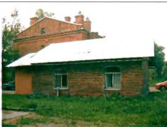
Фото 156. Западный фасад. Общий вид.
