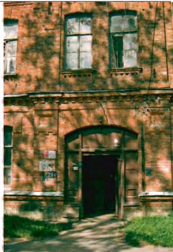
Фото 178. Восточный фасад. Центральная часть. Фрагмент.
