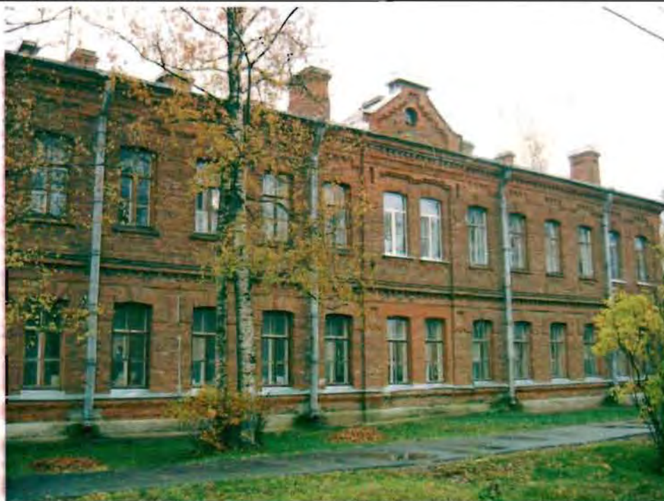
Фото 157. Западный фасад. Общий вид.
