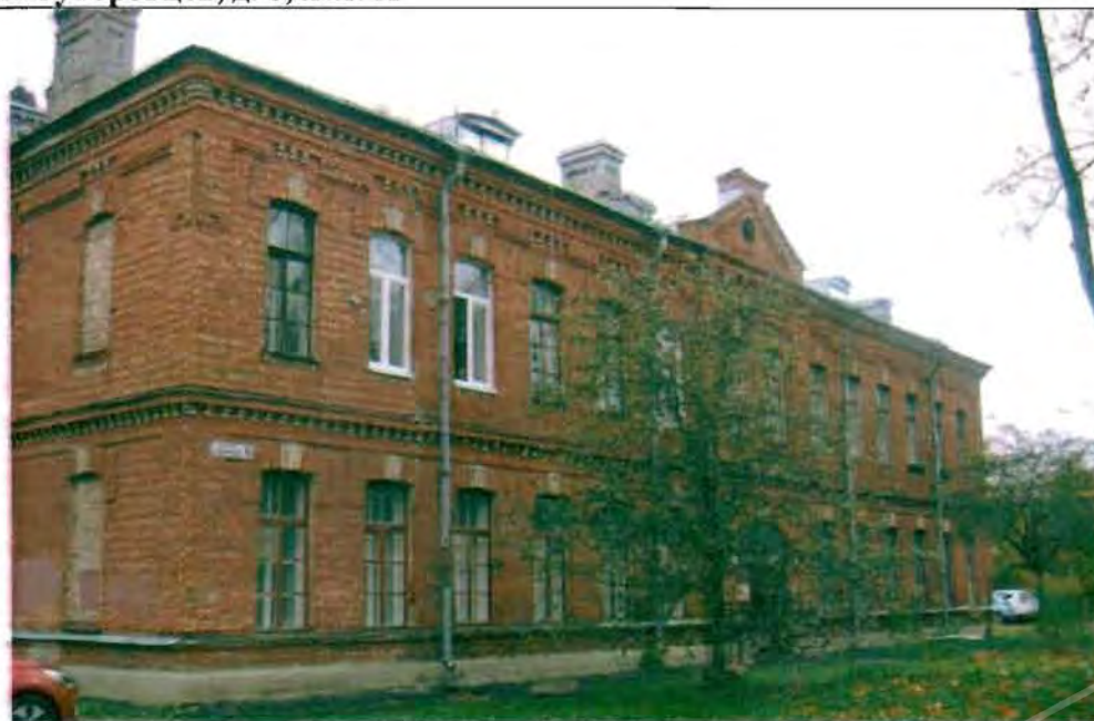
Фото 103. Восточный фасад. Общий вид.
