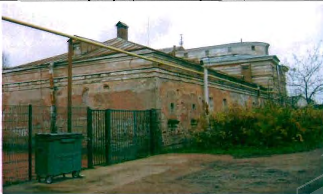
Фото 24. Западный, северный фасады. Общий вид.
