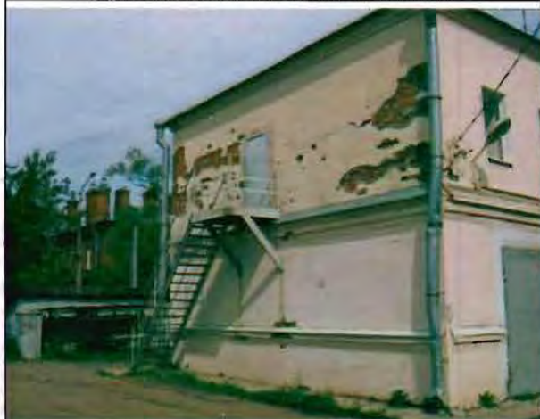
Фото 112. Южный фасад. Общий вид.
