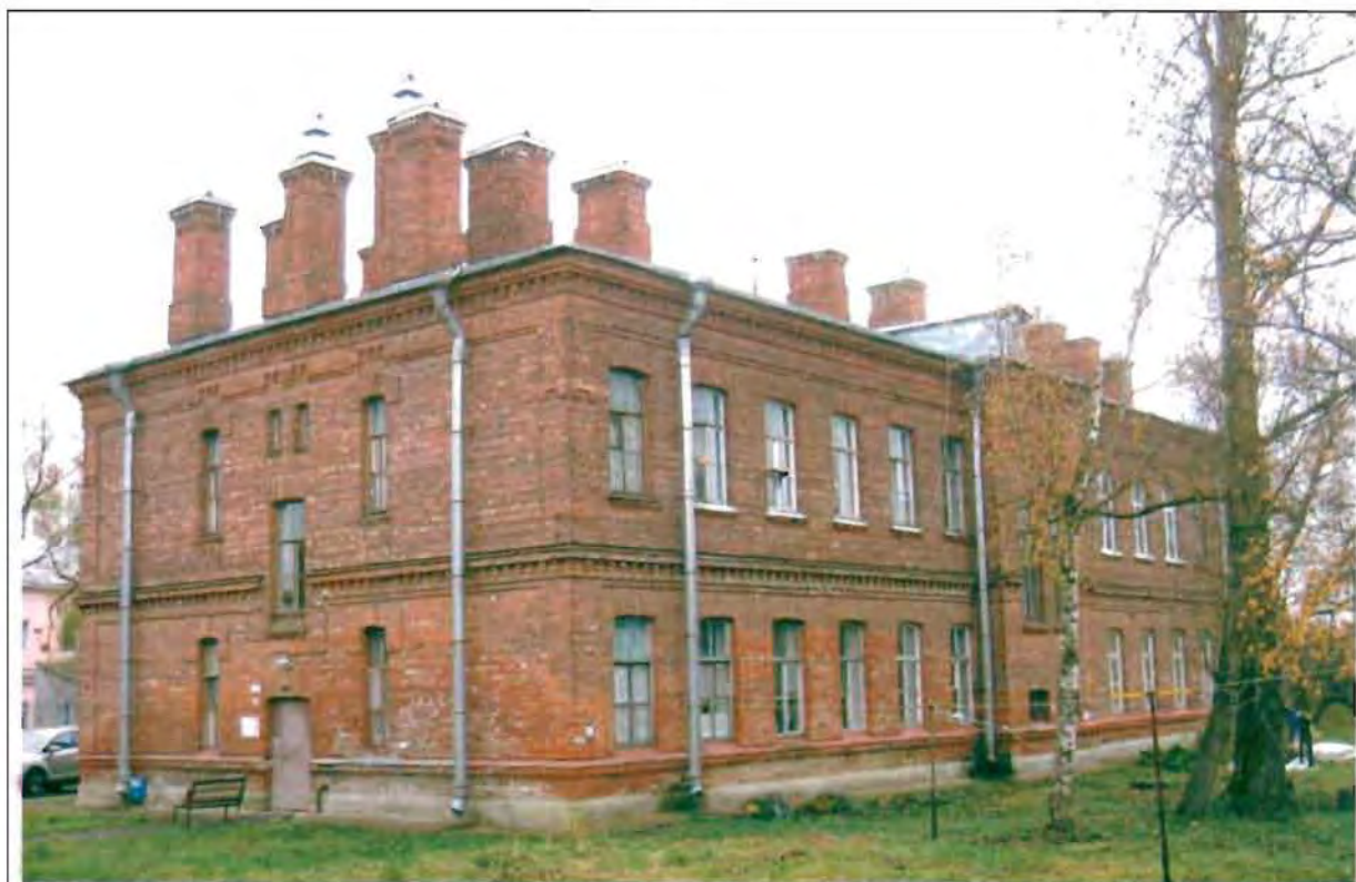
Фото 129. Западный, северный фасады. Общий вид.
