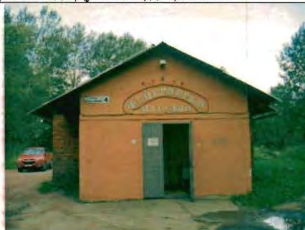
Фото 153. Восточный фасад. Общий вид.
