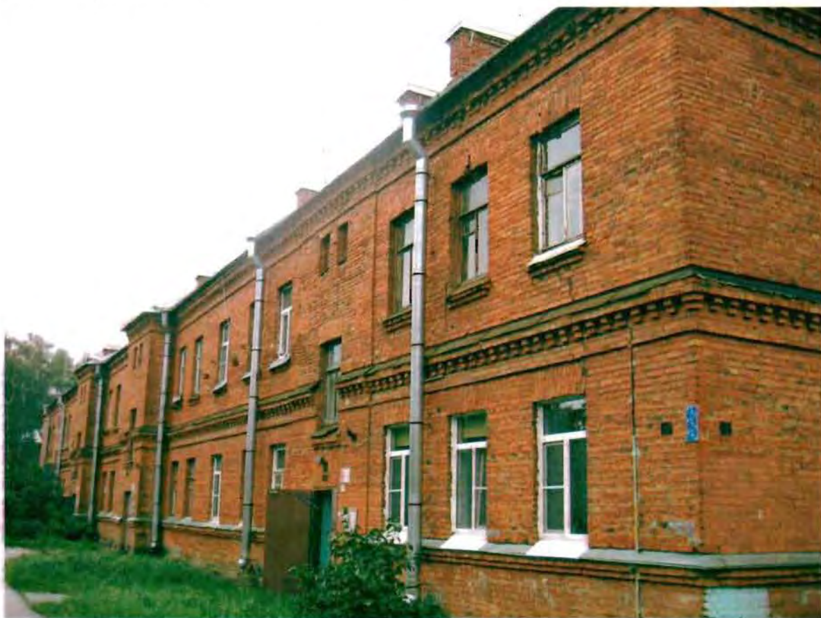
Фото 83. Северный фасад. Общий вид.
