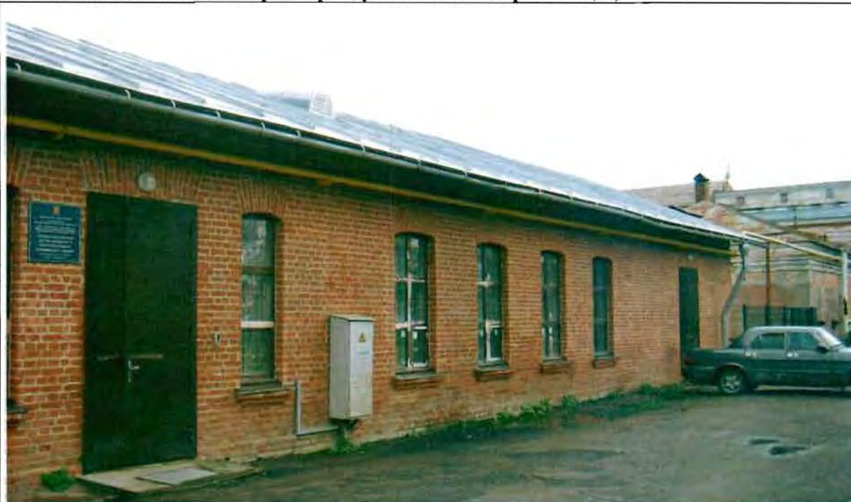
Фото 18. Западный фасад. Общий вид.
