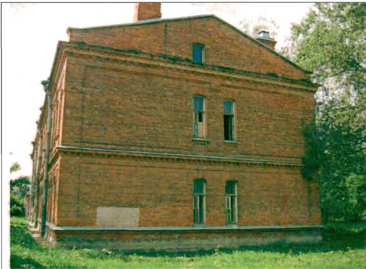
Фото 180. Северный фасад. Общий вид.
