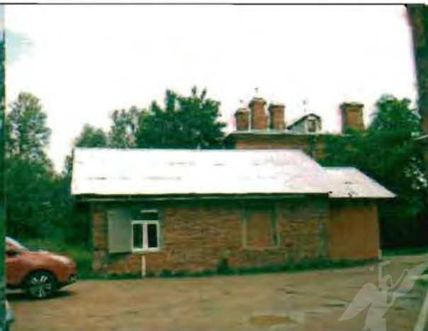
Фото 154. Южный фасад. Общий вид.
