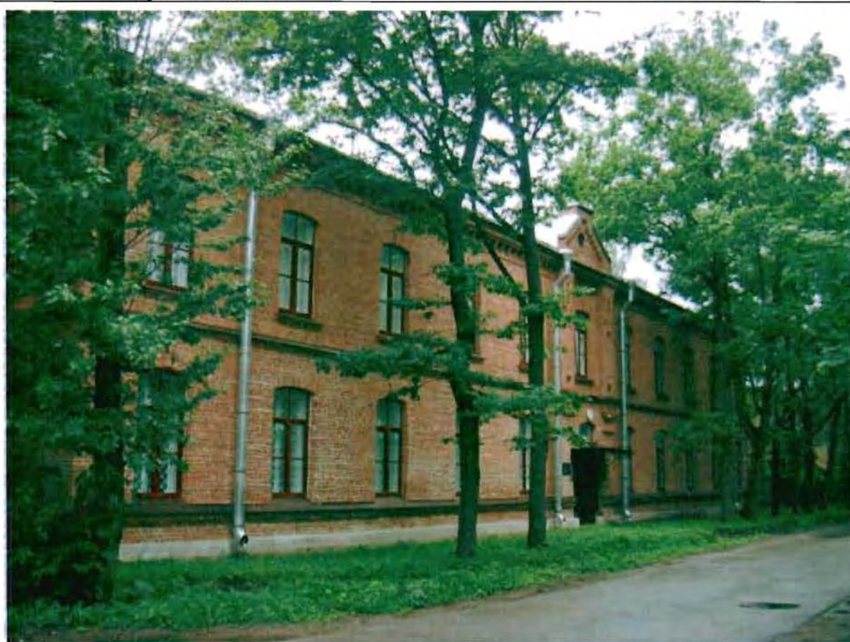
Фото 39. Восточный фасад. Общий вид.
