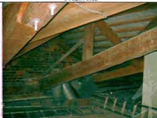
Фото 77. Конструкции крыши. Общий вид.
