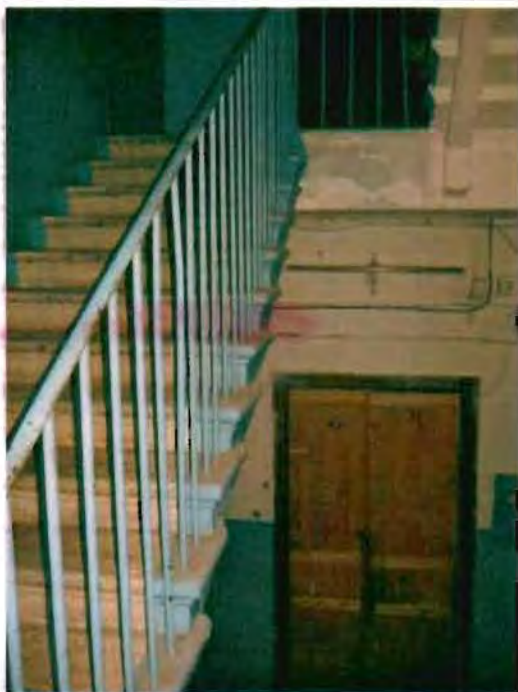
Фото 143. Лестница № 1 в северной части здания. Общий вид.
