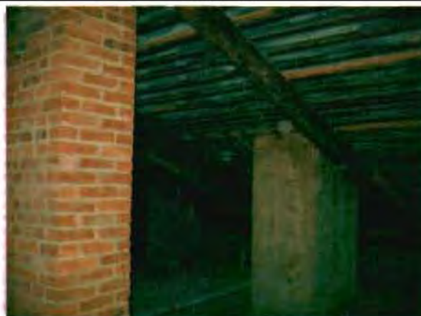
Фото 152. Конструкции крыши. Фрагмент.
