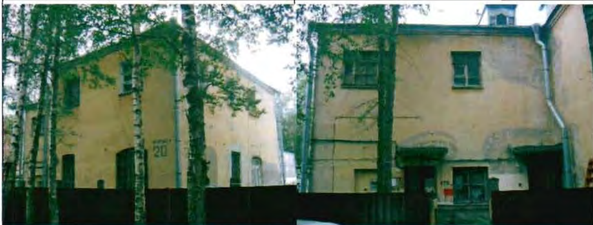
Фото 43. Северный, восточный фасады. Общий вид.
