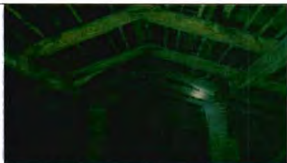
Фото 37. Конструкции крыши. Фрагмент.
