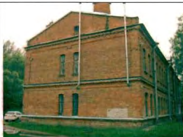
Фото 166. Южный фасад. Общий вид.
