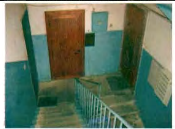
Фото 162. Лестница № 2 в северной части здания. Фрагмент.
