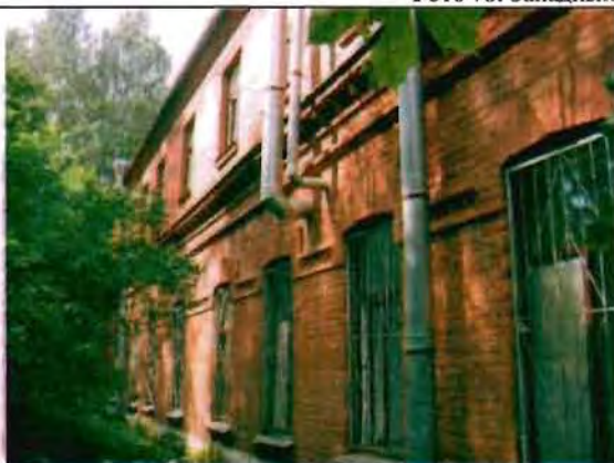
Фото 79. Восточный фасад. Общий вид.
