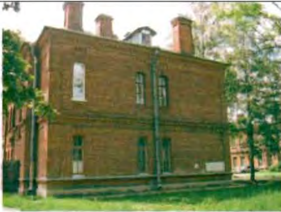
Фото 159. Северный фасад. Общий вид.
