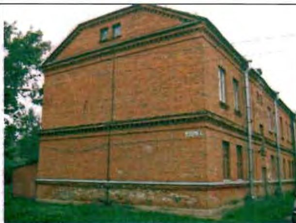
Фото 85. Восточный фасад. Общий вид.
