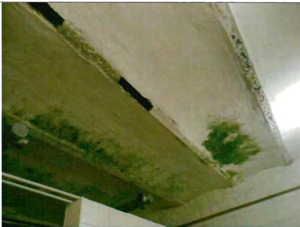
Своды по металлическим балкам. Съемка 27.11.2012, Воронина Н.В.
