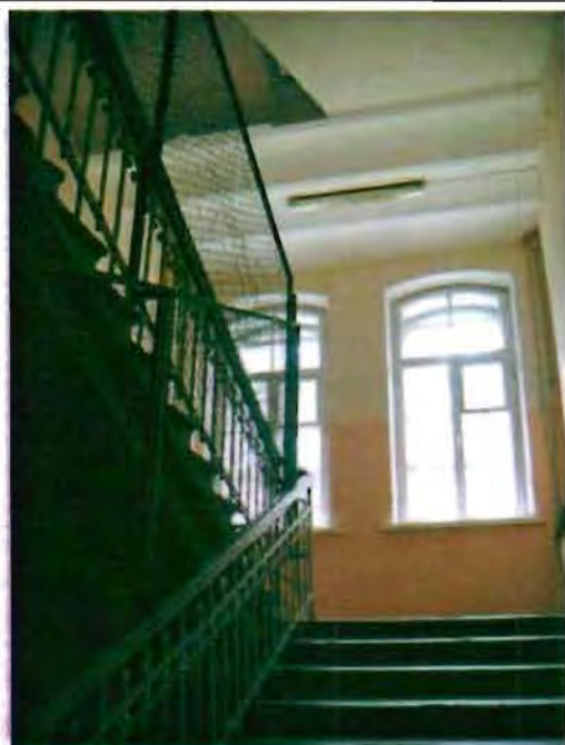
Фото 56. Лестница в центральной части здания. Фрагмент.
