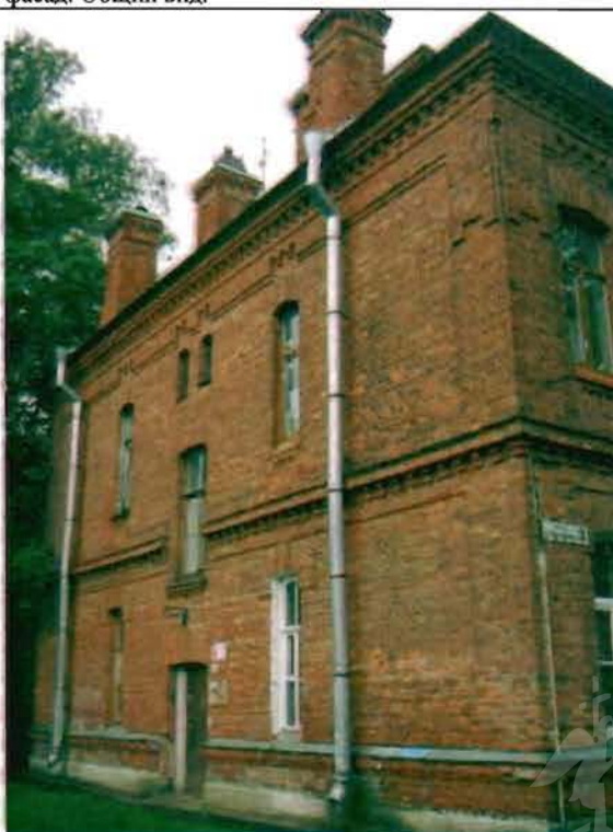
Фото 148. Северный фасад. Общий вид.
