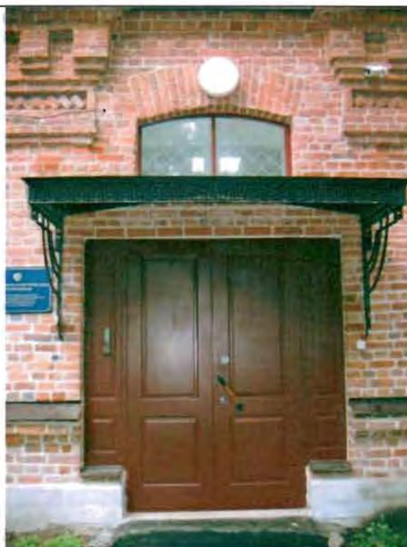
Фото 41. Дверной проем восточного фасада. Общий вид.
