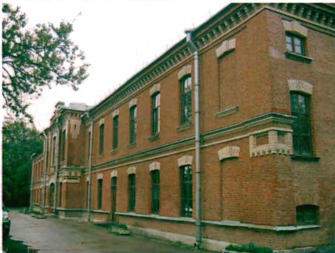
Фото 64. Северный фасад. Общий вид.
