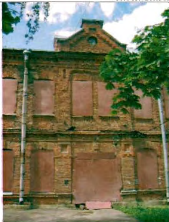
Фото 117. Восточный фасад. Фрагмент центральной части фасада.
