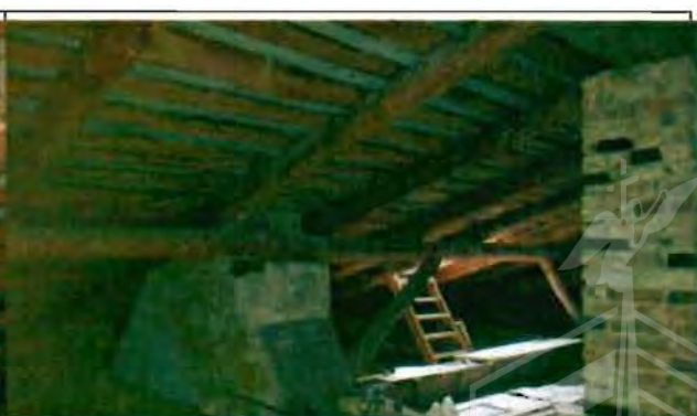
Фото 63. Конструкции крыши. Общий вид.
