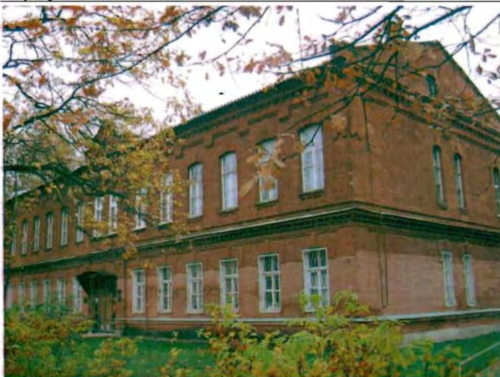
Фото 89. Западный, южный фасады. Общий вид.
