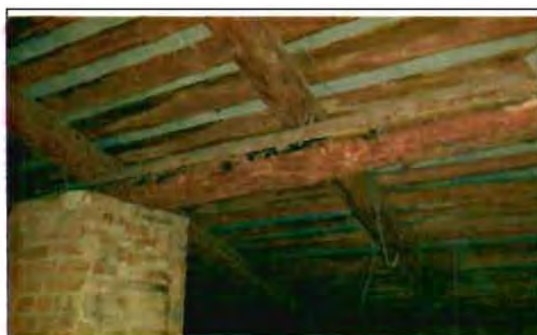
Фото 62. Конструкции крыши. Общий вид.
