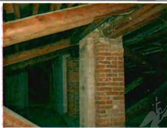
Фото 142. Конструкции крыши. Фрагмент.
