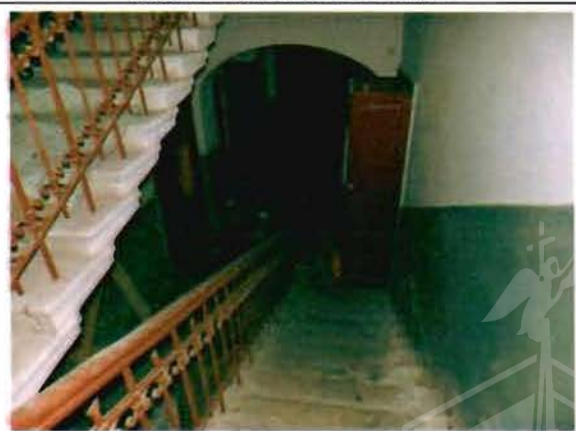
Фото 123. Парадная лестница в центральной части здания. Фрагмент.
