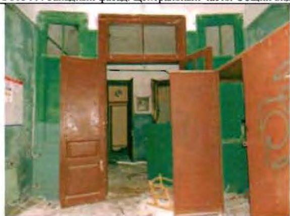
Фото 101. Дверной проем тамбура. Общий вид.
