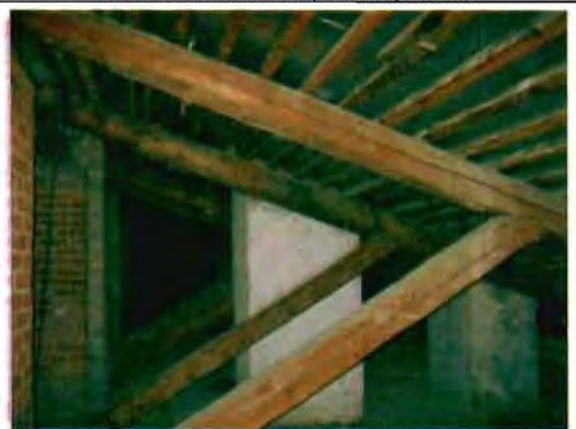
Фото 141. Конструкции крыши. Фрагмент.
