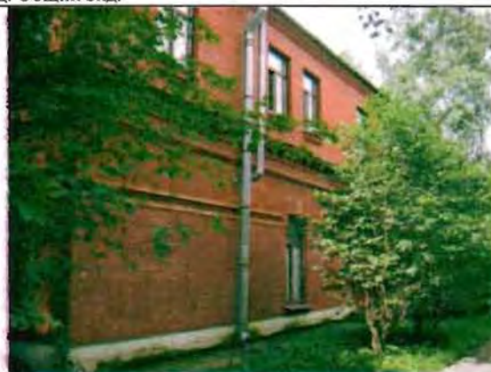
Фото 80. Северный фасад. Фрагмент.
