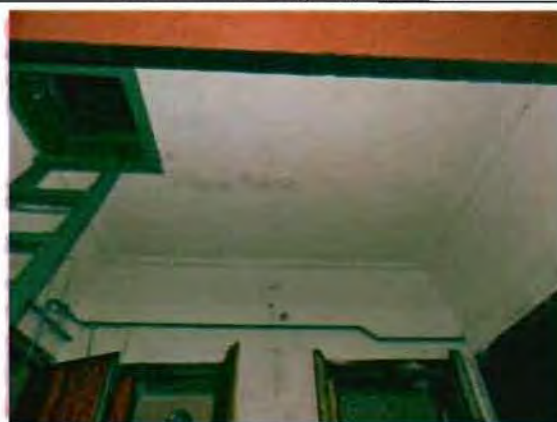
Фото 102. Отделка потолка тамбура. Общий вид.
