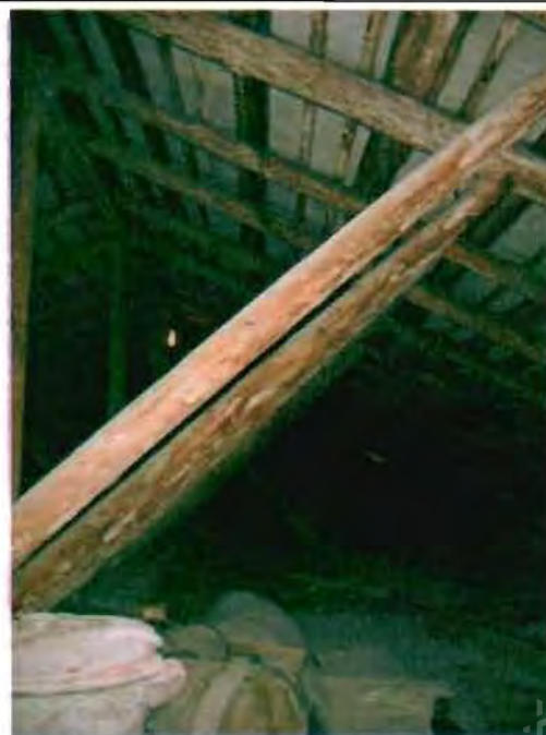
Фото 27. Конструкции крыши. Фрагмент.
