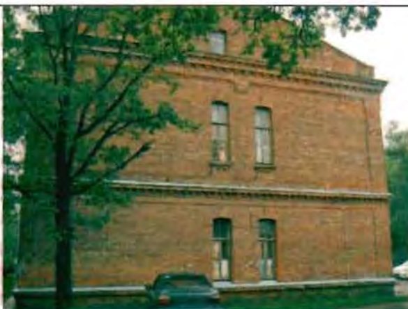
Фото 167. Северный фасад. Общий вид.
