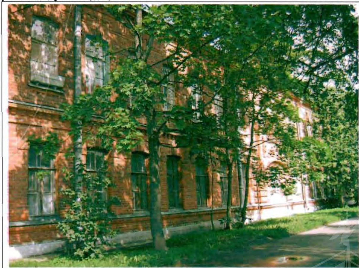
Фото 136. Восточный фасад. Общий вид.
