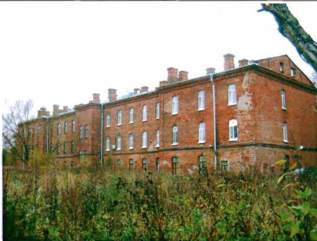
Фото 14. Восточный фасад. Общий вид.
