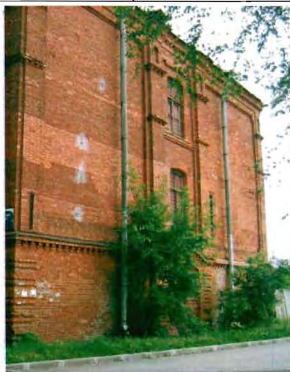
Фото 5. Южный фасад. Общий вид.
