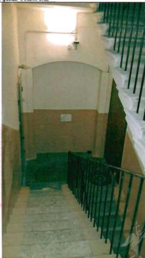
Фото 173. Лестница № 1 в северной части здания. Фрагмент.
