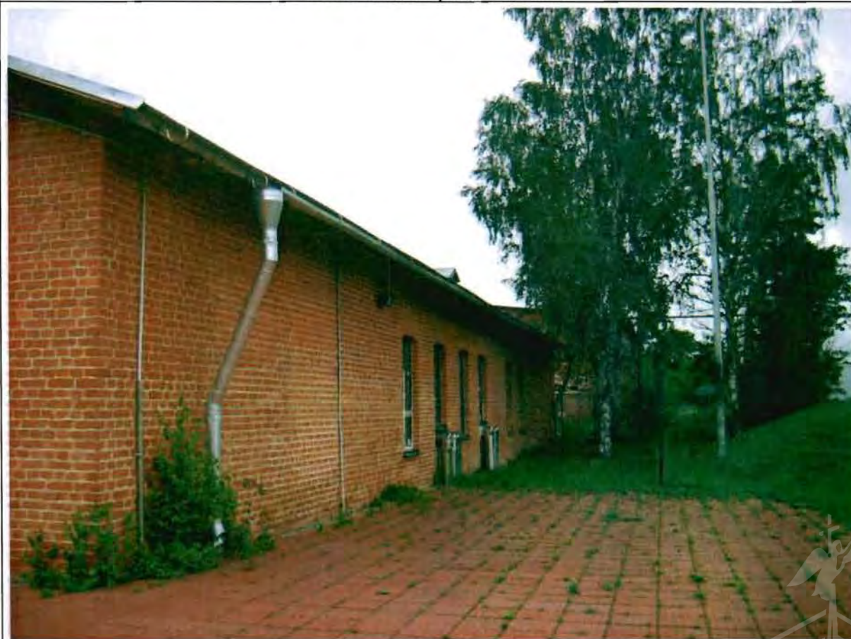
Фото 19. Восточный фасад. Общий вид.
