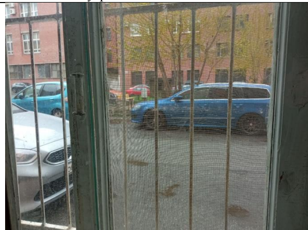
Фото 19. Внутреннее состояние Объекта оценки
