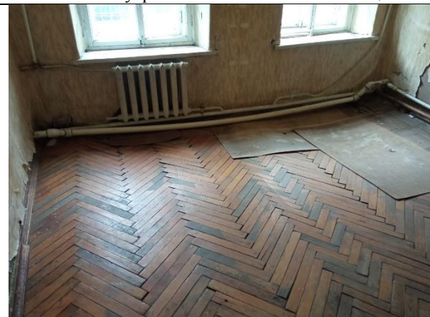
Фото 16. Внутреннее состояние Объекта оценки
