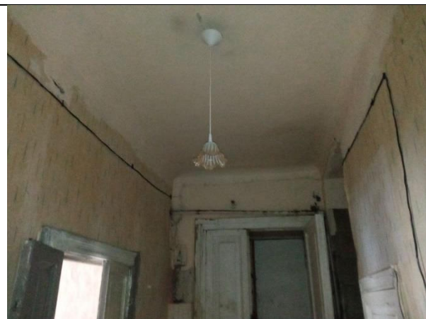
Фото 13. Внутреннее состояние Объекта оценки
