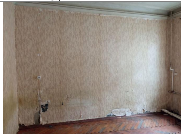
Фото 15. Внутреннее состояние Объекта оценки
