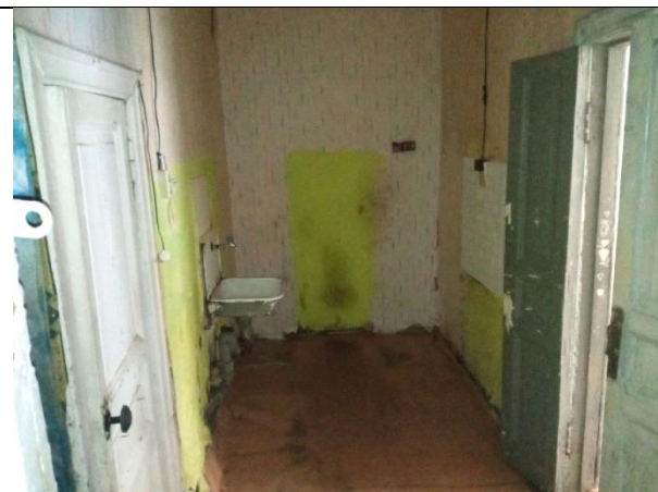
Фото 14. Внутреннее состояние Объекта оценки
