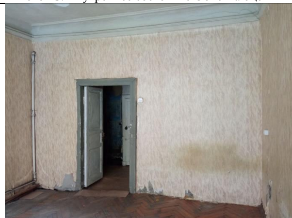
Фото 17. Внутреннее состояние Объекта оценки
