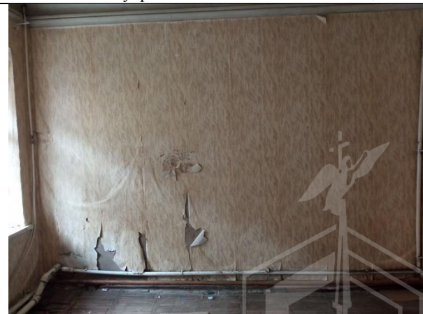
Фото 20. Внутреннее состояние Объекта оценки
