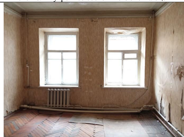
Фото 18. Внутреннее состояние Объекта оценки
