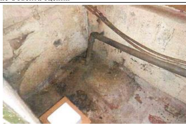
Фото 8. Внутреннее состояние Объекта оценки
