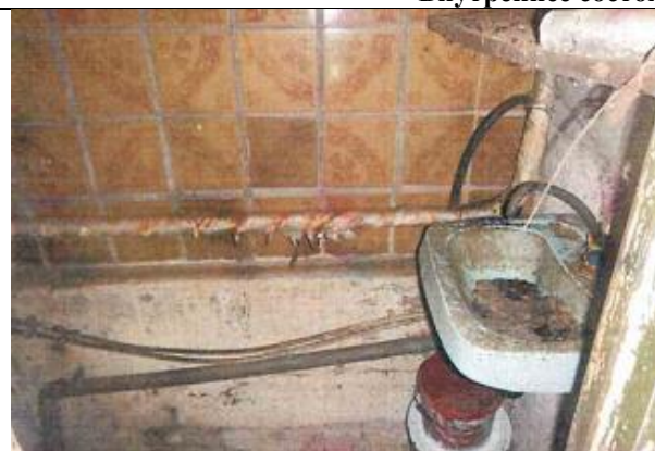
Фото 7. Внутреннее состояние Объекта оценки
