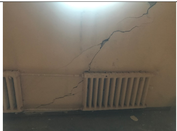
Фото 12. Часть помещения 1. Состояние стен.
