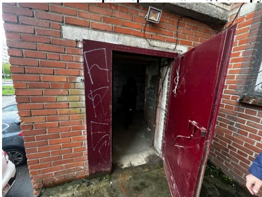
Фото 5. Общий вход со двора
