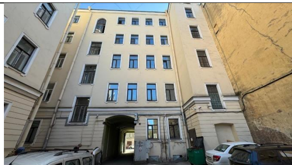
Фото 2. Вид здания, в котором расположен Объект оценки
