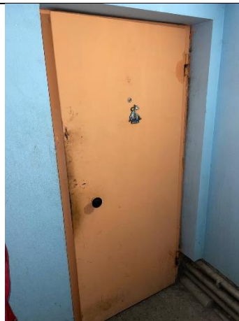
Фото № 12 – Вход в помещение
