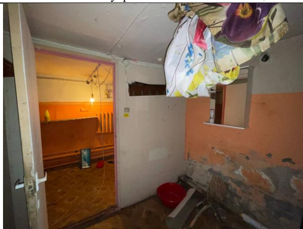
Фото № 16 – Внутреннее состояние помещения
