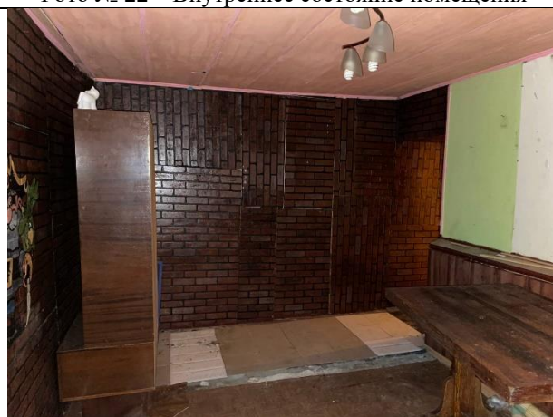
Фото № 24 – Внутреннее состояние помещения
