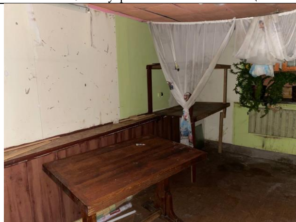
Фото № 22 – Внутреннее состояние помещения
