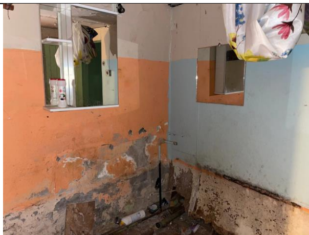
Фото № 14 – Внутреннее состояние помещения
