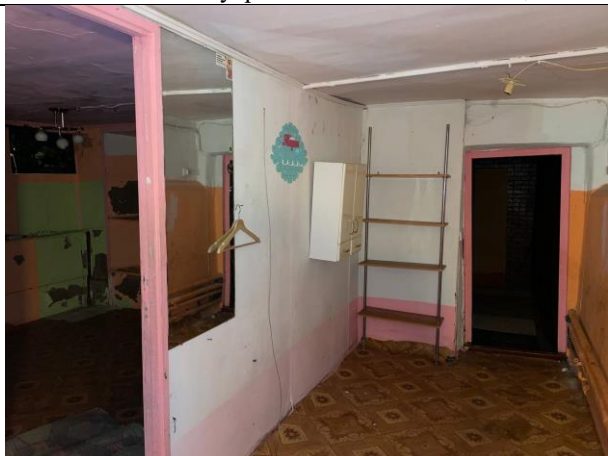
Фото № 17 – Внутреннее состояние помещения
