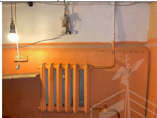
Фото № 26 – Внутреннее состояние помещения
