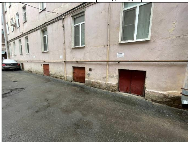
Фото № 9 – Окна помещения
