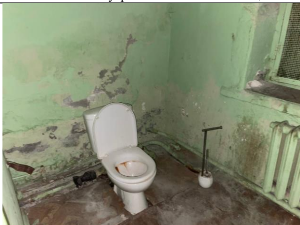
Фото № 15 – Внутреннее состояние помещения
