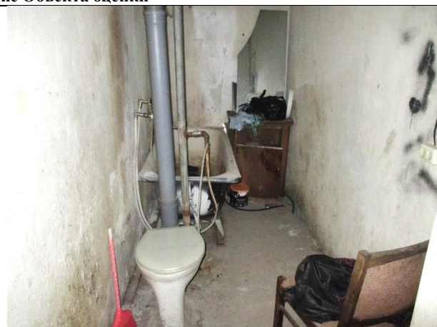
Фото 10. Внутреннее состояние Объекта оценки
