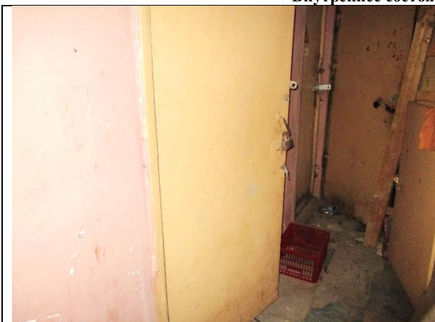
Фото 9. Внутреннее состояние Объекта оценки
