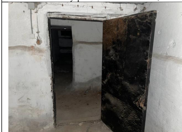
Фото № 19 – Внутреннее состояние помещения
