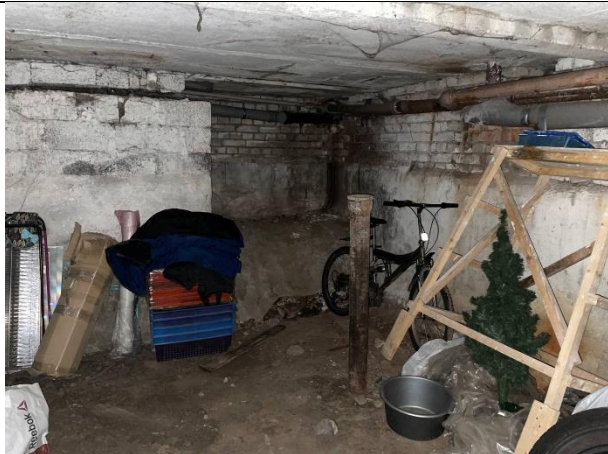
Фото № 23 – Внутреннее состояние помещения
