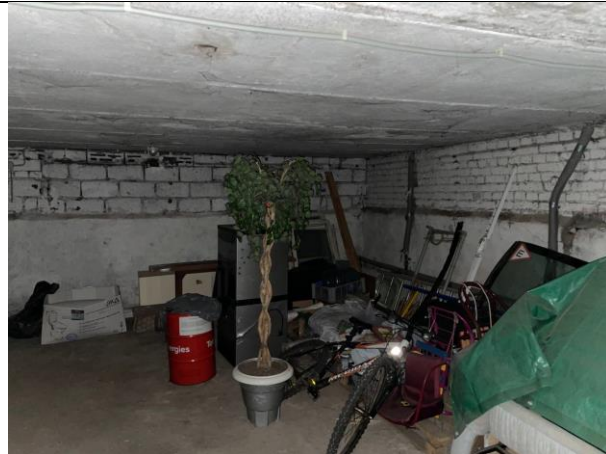
Фото № 24 – Внутреннее состояние помещения
