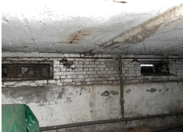
Фото № 25 – Внутреннее состояние помещения
