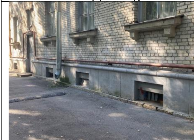
Фото № 9 – Окна помещения
