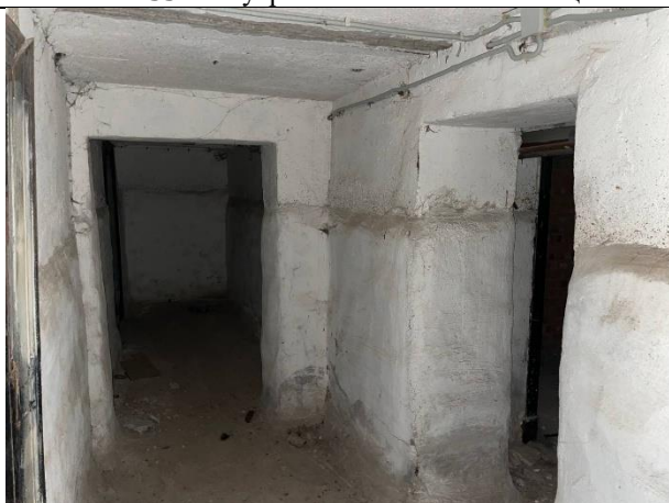
Фото № 35 – Внутреннее состояние помещения
