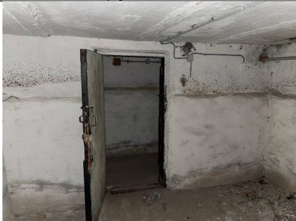
Фото № 33 – Внутреннее состояние помещения
