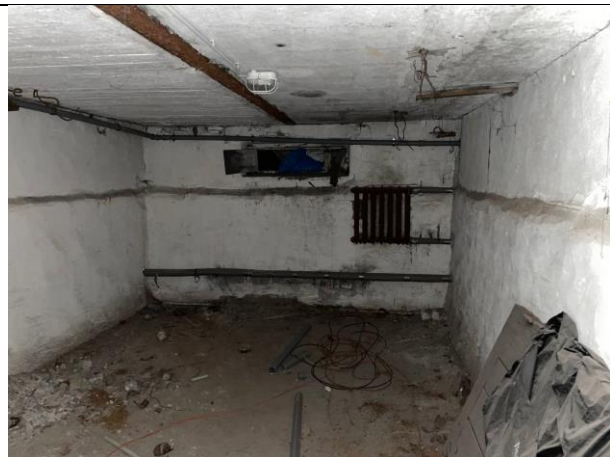
Фото № 16 – Внутреннее состояние помещения
