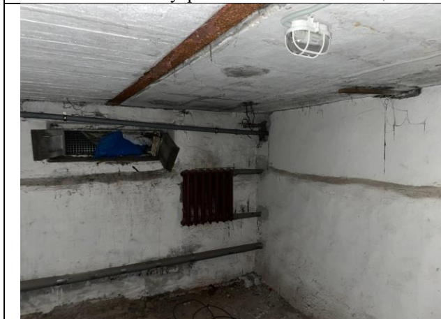
Фото № 17 – Внутреннее состояние помещения
