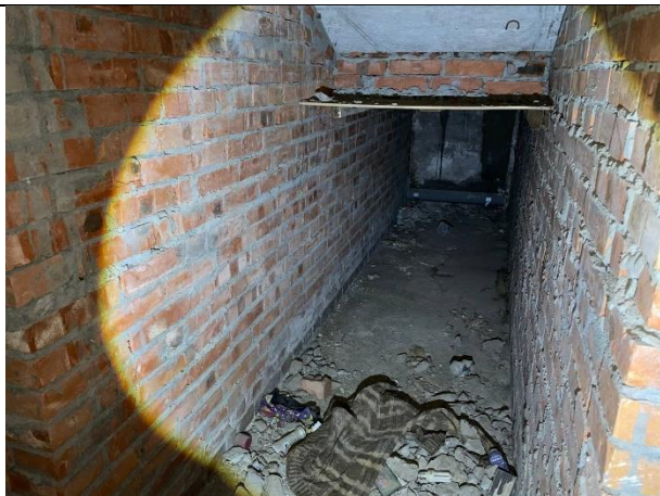
Фото № 31 – Внутреннее состояние помещения
