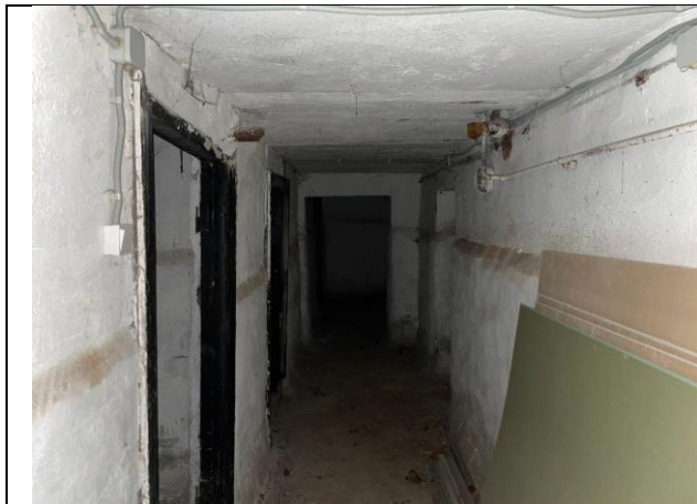
Фото № 15 – Внутреннее состояние помещения
