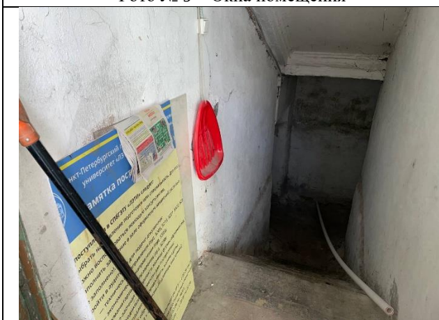
Фото № 11 – Внутреннее состояние помещения
