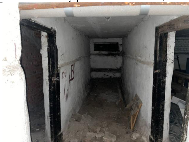
Фото № 20 – Внутреннее состояние помещения
