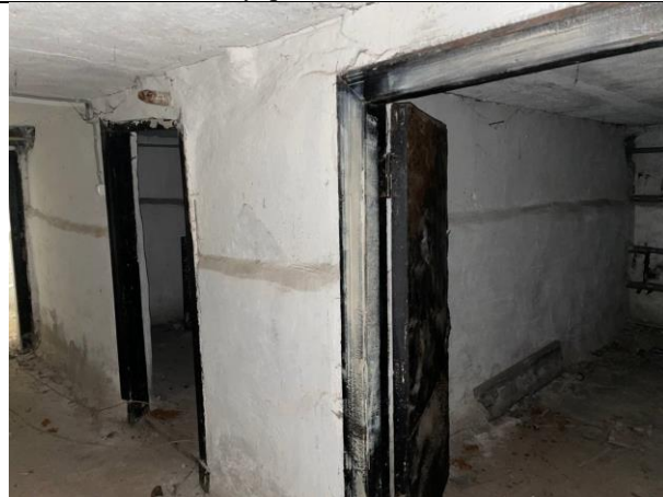
Фото № 34 – Внутреннее состояние помещения
