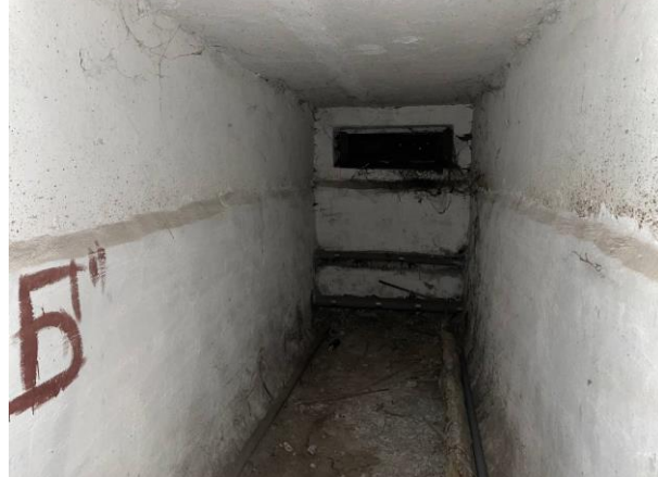
Фото № 26 – Внутреннее состояние помещения
