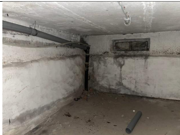
Фото № 32 – Внутреннее состояние помещения
