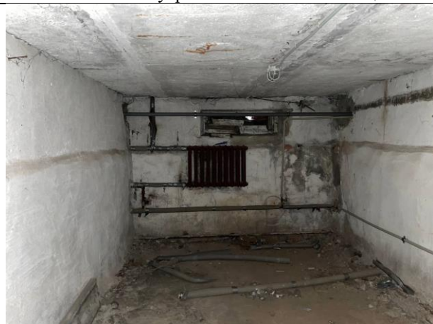
Фото № 18 – Внутреннее состояние помещения
