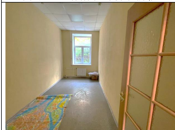
Фото 29. Типичное состояние Объекта оценки
