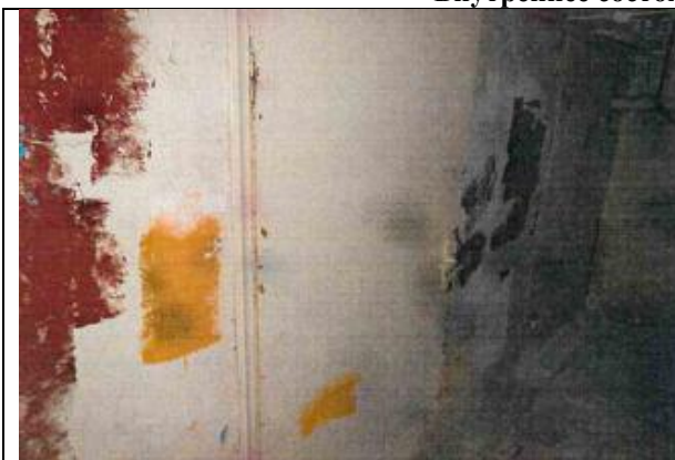
Фото 7. Внутреннее состояние Объекта оценки
