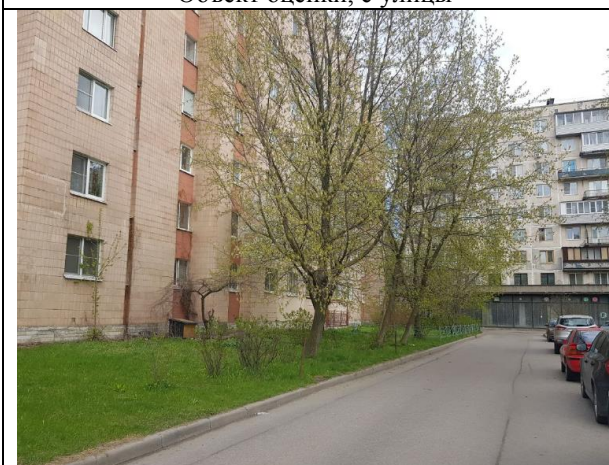
Фото 3 Вид здания, в котором расположен Объект оценки
