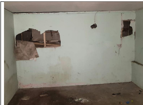
Фото 13. Внутреннее состояние Объекта оценки
