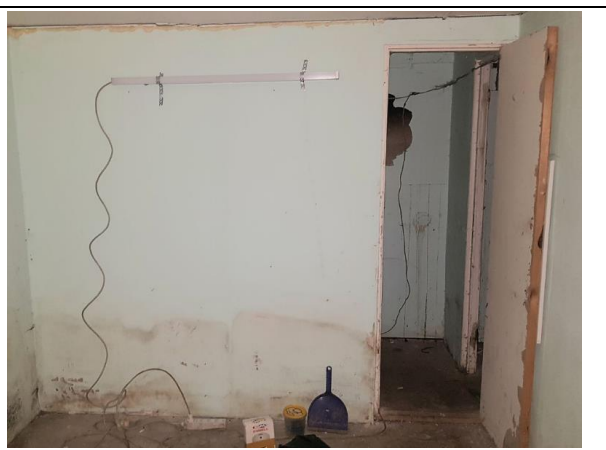
Фото 14. Внутреннее состояние Объекта оценки
