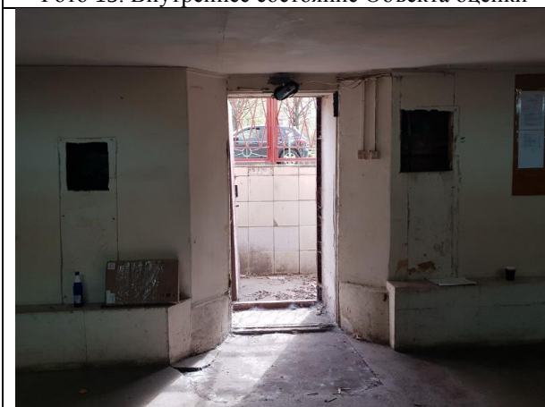
Фото 17. Внутреннее состояние Объекта оценки
