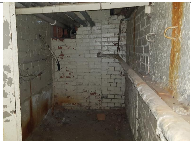
Фото 10. Внутреннее состояние Объекта оценки
