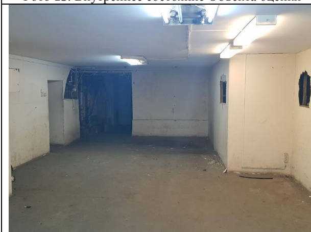
Фото 15. Внутреннее состояние Объекта оценки
