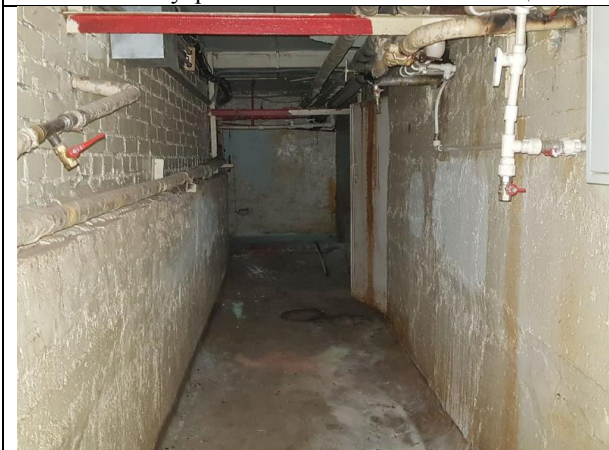
Фото 11. Внутреннее состояние Объекта оценки
