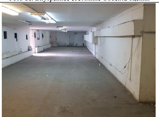
Фото 18. Внутреннее состояние Объекта оценки
