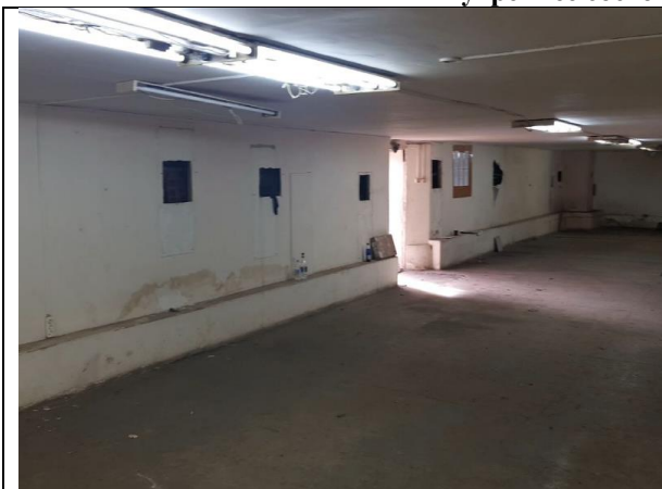
Фото 9. Внутреннее состояние Объекта оценки
